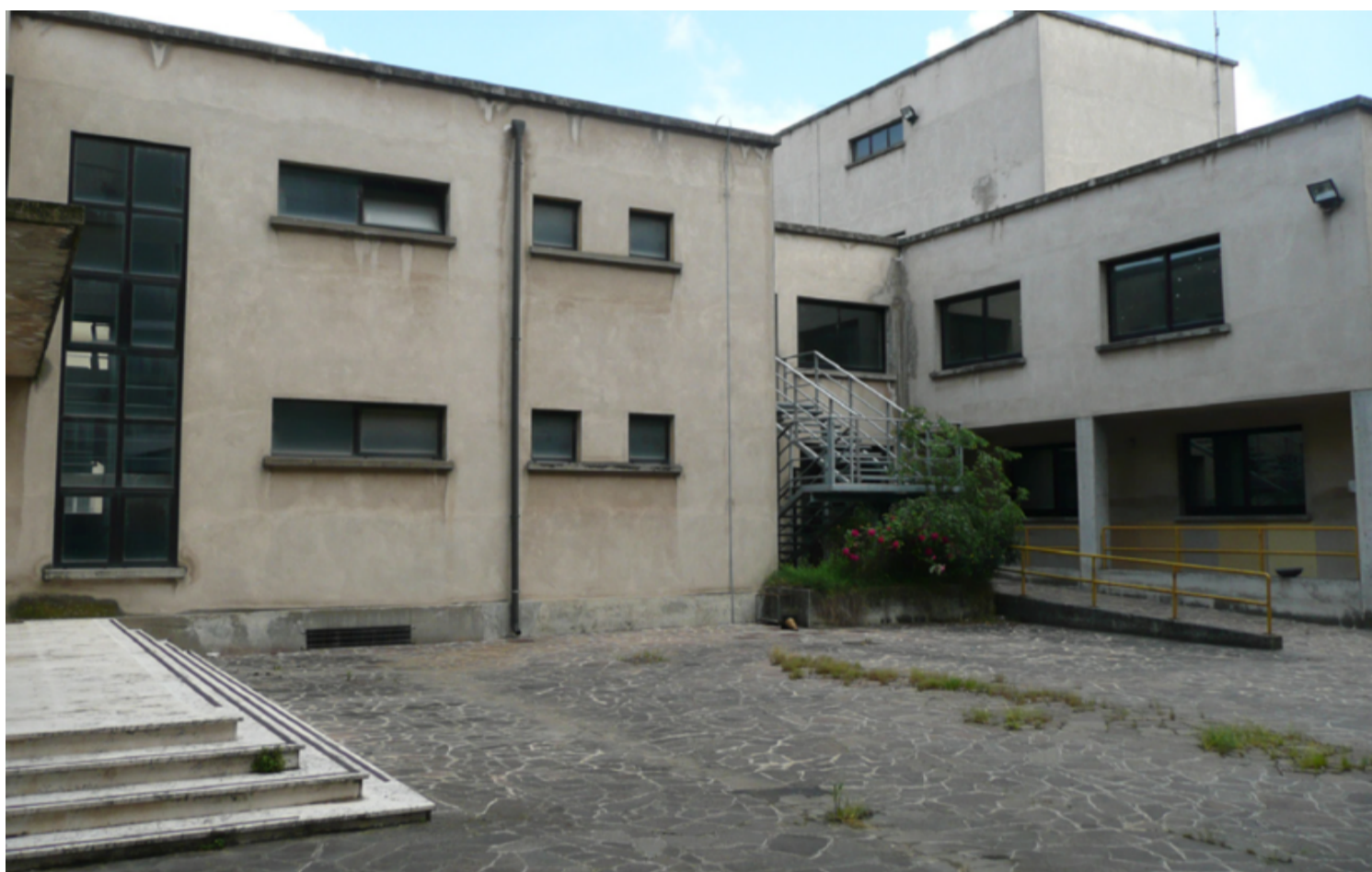
Fig.37_C. Costantini, casa del balilla di Mantova. Lato su cortile interno. Foto 2012.
