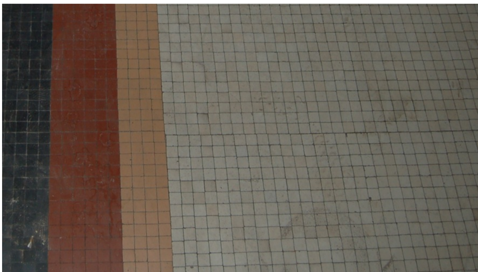
Fig.34 _C. Costantini, casa del balilla di Mantova, Costantino Costantini. Pavimentazione originale. Foto 2012.
