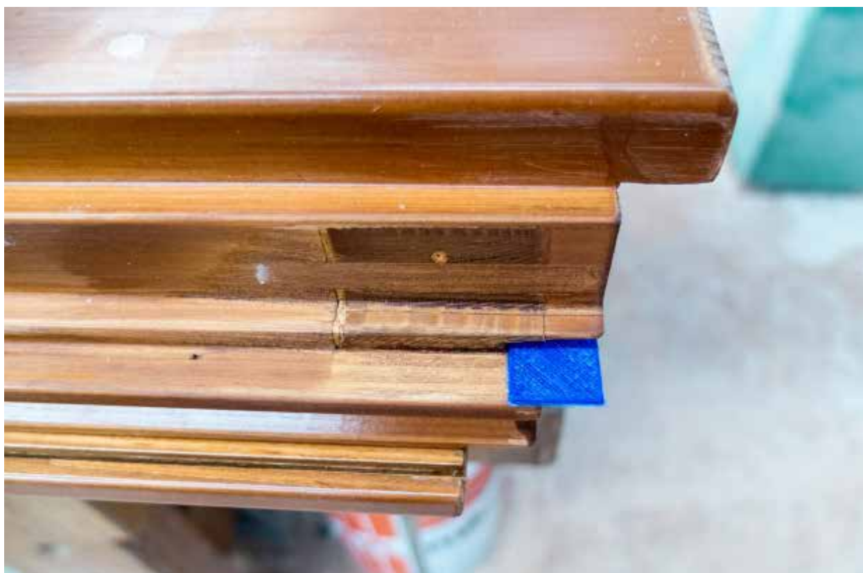
Figura 136_Installazione degli inserti sul serramento.
