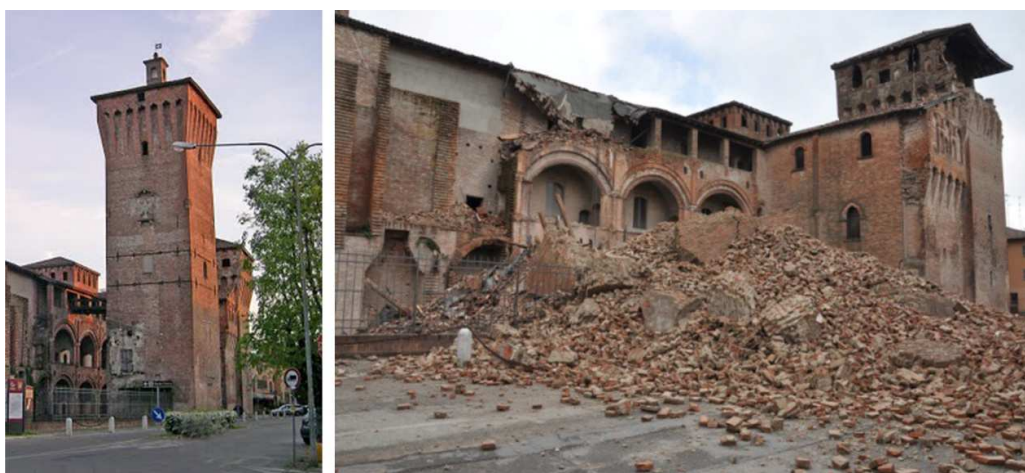
Figura 3.7 – Mastio del Castello delle Rocche prima (a) e dopo (b) il sisma del mattino.
