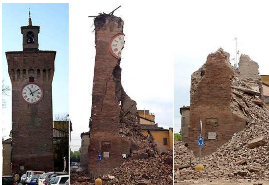
Figura 3.6 – Torre dell'Orologio prima del 20 maggio (a), dopo la prima scossa del mattino (b), dopo la scossa del pomeriggio (c).
