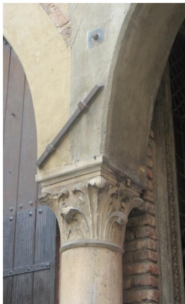
Figura 145. Capochiave a paletto abbinato a due catene, Piazza dei mercanti, Milano.
