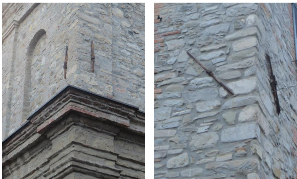
Figura 19. Catene applicate per vincolare mutuamente le pareti ortogonali. Chiesa di San Lorenzo ed edificio attiguo, Bobbio.
