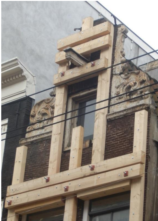
Figura 56. Esempio di utilizzo dei tiranti quali opere provvisorie atte a contenere i cedimenti delle fondazioni, Amsterdam.
