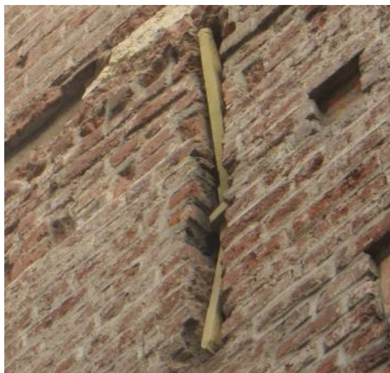
Figura 143. Capochiave eccessivamente deformato, Veneranda fabbrica del Duomo, Milano.
