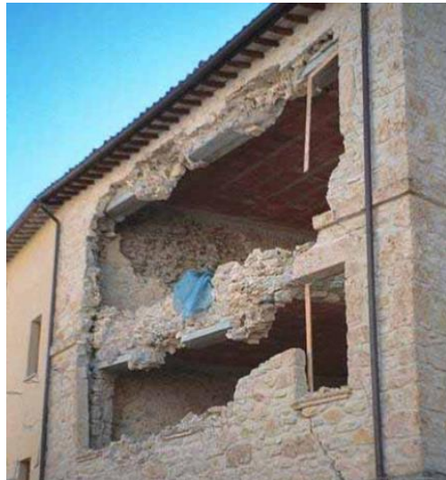
Figura 55. Esempio di meccanismo locale per flessione verticale dovuto a un insufficiente ammassamento della parete al solaio [50].
