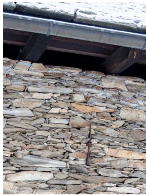
Figura 16. Catene per contenere la spinta della copertura, Abbazia di San Colombano, Bobbio.
