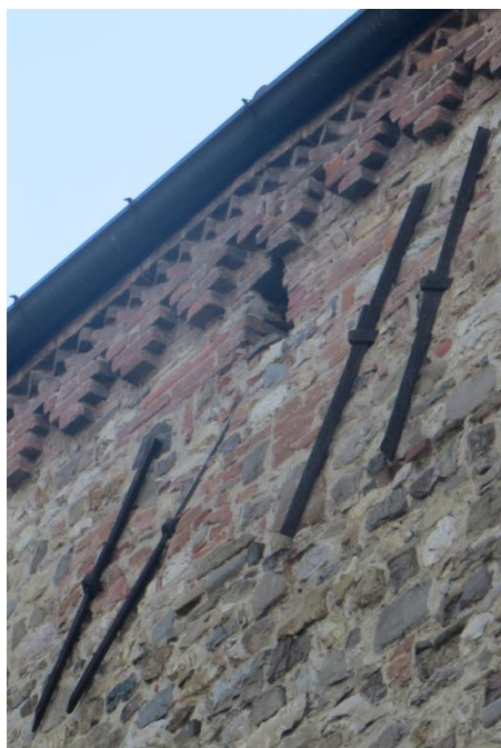
Figura 16. Catene per contenere la spinta della copertura, Abbazia di San Colombano, Bobbio.
