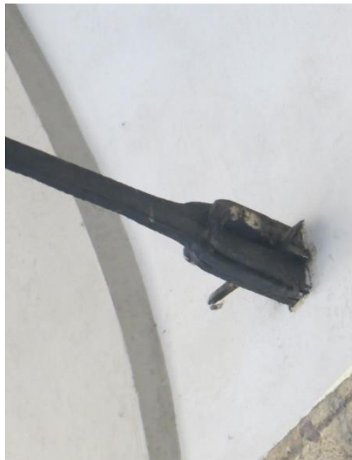
Figura 5. Porzione di una catena metallica a sezione rettangolare proveniente dal Duomo di Milano.
