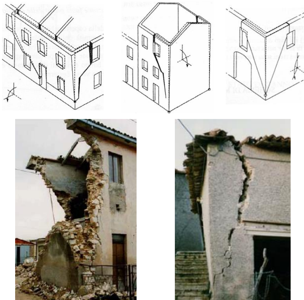
Figura 86. Schema e fotografie del ribaltamento in esame [50].
