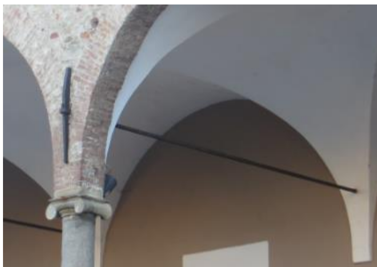
Figura 12. Camminamento esterno dell'abbazia di San Colombano (Bobbio).
