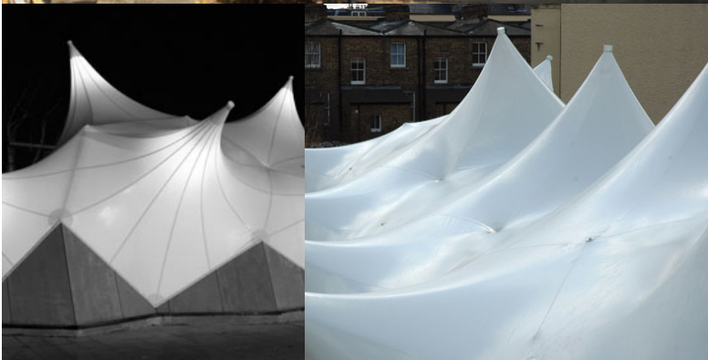
(Fig. 2.3.1_61) Dettaglio della copertura in tessuto
