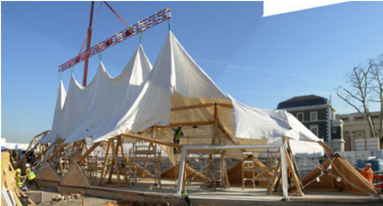
(Fig. 2.3.1_60) Montaggio della copertura in tessuto
