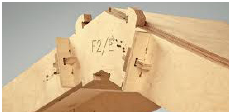
(Fig. 2.3.1_9) Dettaglio connettori
