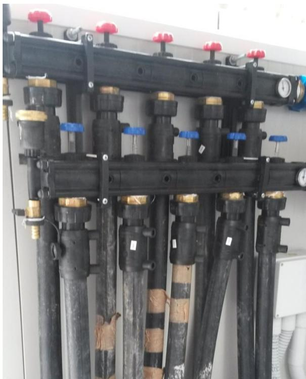
Figura 20. Collettore delle 5 sonde geotermiche
