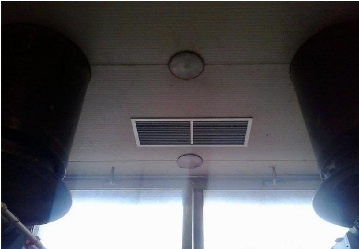
Figura 10. Bocchetta di estrazione dell'aria nella sala post-svezzamento di suinetti
