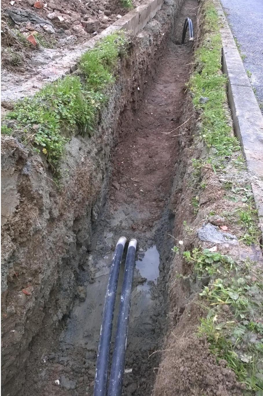
Figura 31. Scavo della trincea per i collegamenti orizzontali tra BHE
