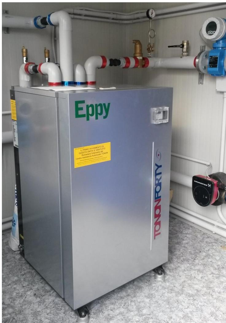
Figura 19. Pompa di Calore installata
