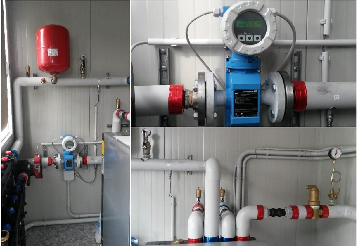
Figura 41. Sensori di misura e misuratori di portata inseriti nelle condotte idrauliche di collegamento tra sonde geotermiche e pompa di calore
