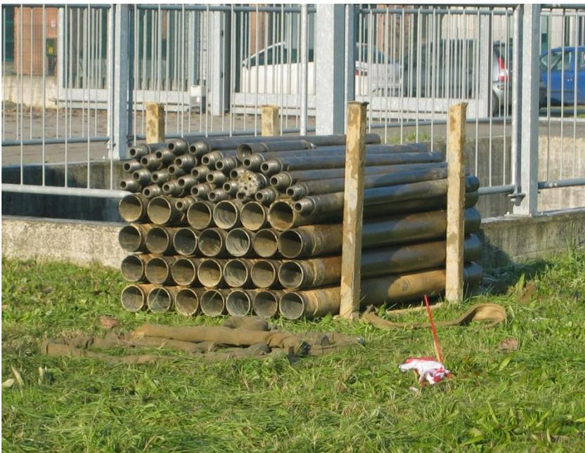
Figura 29. Camicie di rivestimento utilizzate per l'installazione dei BHE nel terreno
