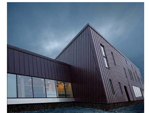
Fig.7.29 Riferimento: pareti metalliche inclinate di colore scuro nel Dronning Ingrid's Hospital
