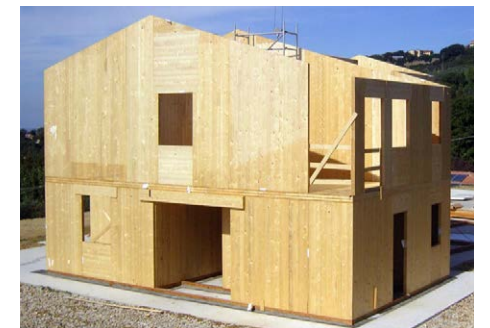
Fig.9.3 Esempio di struttura in X-lam
