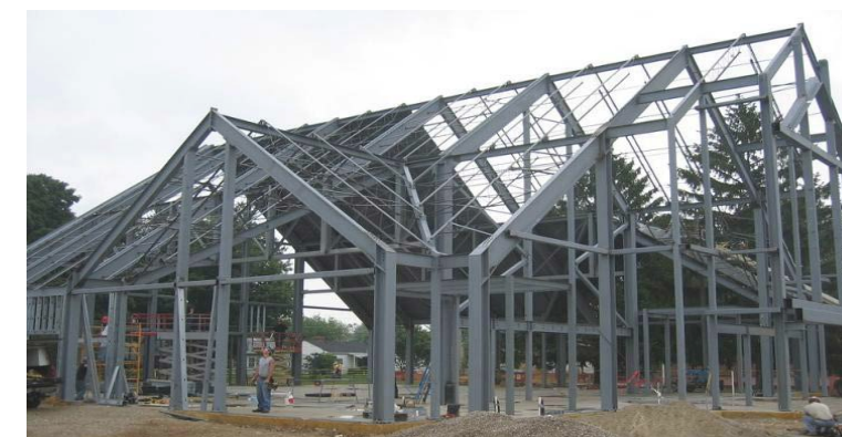
Fig.9.83 Esempio di telaio "Steel moment frame" telaio resistente e momento per mezzo di connessioni rigide fra travi e colonne.
