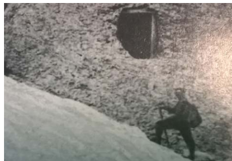
Fig.1.11 Vestibolo di ingresso al rifugio della Marmolada del 1877
