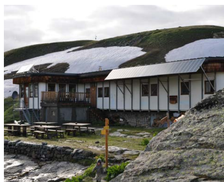
Fig. 1.38 Il rifugio delle Evettes e l'uso dei pannelli prefabbricati, 1965
