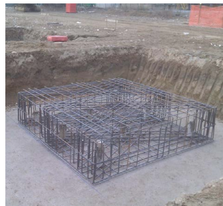
Fig.9.84 Armatura in acciaio di plinto di fondazione gettato in opera
