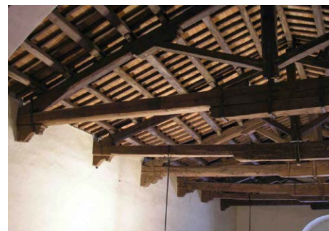
Fig.9.40 Collegamenti di carpenteria lignea tipici delle tradizionali costruzioni storiche
