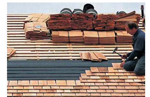
Fig.7.42 Scandole lignee necessitano di tempi di posa molto lunghi
