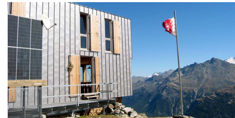
Fig.5.48 Impianto fotovoltaico Topalihütte
