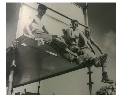
Fig. 1.30 Le strutture per bivacchi di Perriand in tubolari metallici e pannelli standard
