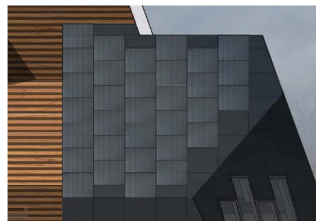
Fig. 7.40 La copertura fotovoltaica del volume della sala espositiva/corsi
