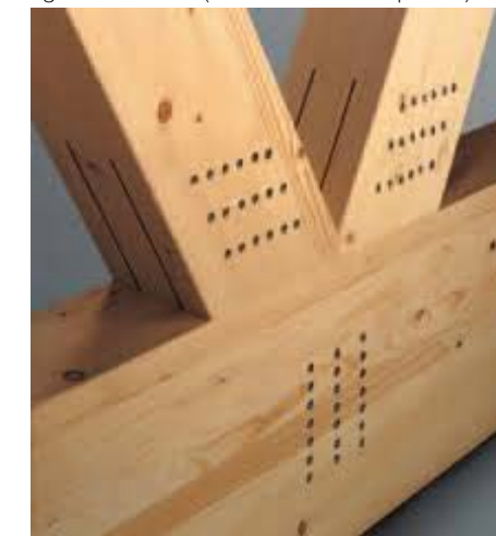
Fig.9.43 Collegamento meccanico con l'ausilio di piastre in acciaio
