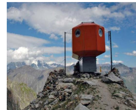
Fig. 1.39 Il bivacco del Dolent del 1973 calato in elicottero e con scocca in poliestere
