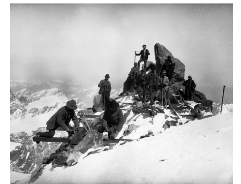
Fig. 1.22 Le prime travi lignee della capanna Regina Margherita nel 1892
