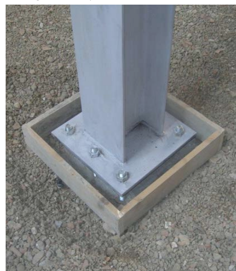
Fig.9.85 Piatto di collegamento colonna-plinto
