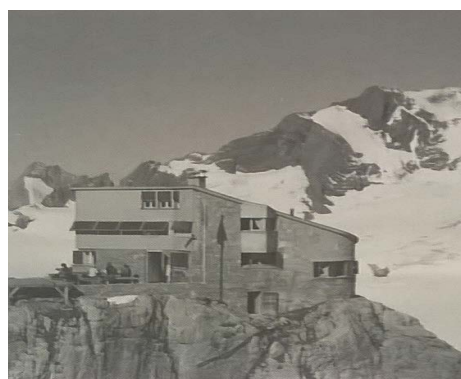
Fig. 1.28 Le aperture irregolari, le finestre a nastro e la copertura a singola falda della Planurahütte
