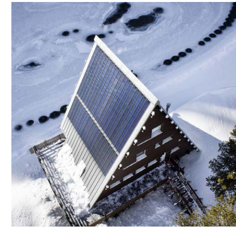
Fig.5.41 Impianto fotovoltaico Rifugio Mollino
