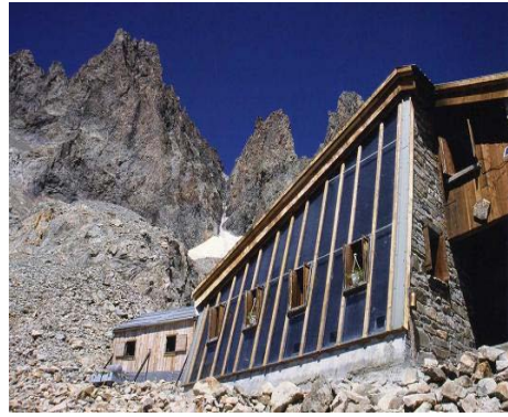
Fig. 1.50 Il "muro di Trombe" realizzato da Zanassi all'Adèle Planchard nel 1982
