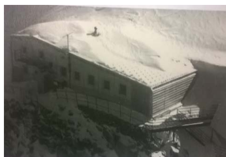
Fig. 1.36 Il Goûter di Lederlin e Kaminsky con struttura in acciaio e rivestimento in alluminio
