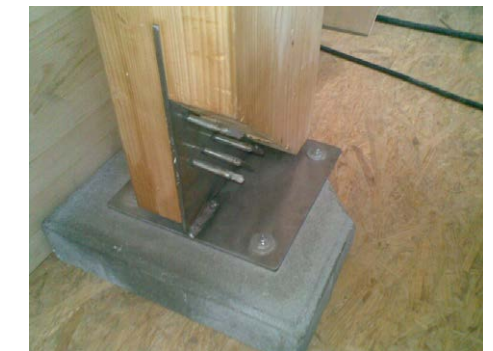
Fig.9.56 Esempio di giunto portapilastrò a scomparsa con fresatura
