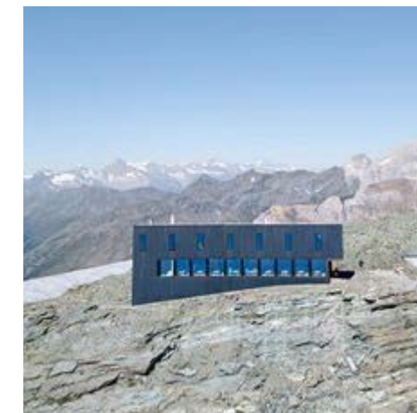
Fig.5.23 Pannelli fotovoltaici integrati nella facciata del Tracuit Hütte
