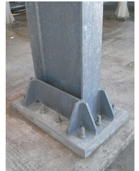
Fig.9.1 Esempio di plinto per struttura in acciaio
