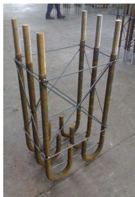
Fig.9.86 Tirafondi di ancoraggio colonna-plinto realizzati prima del getto
