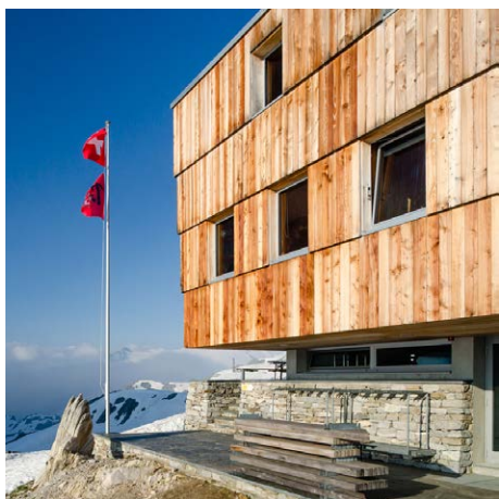
Fig.5.60 Facciata in larice della Capanna Cristallina
