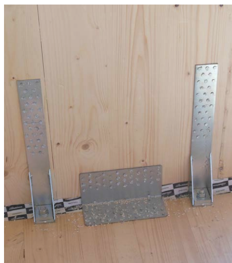
Fig.9.12 Piastre angolari di presidio al sollevamento "hold-down"
