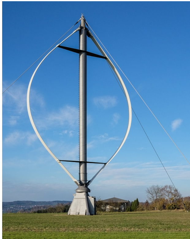
Figura 4.4: Turbina Darrieus geometria Troposkein
