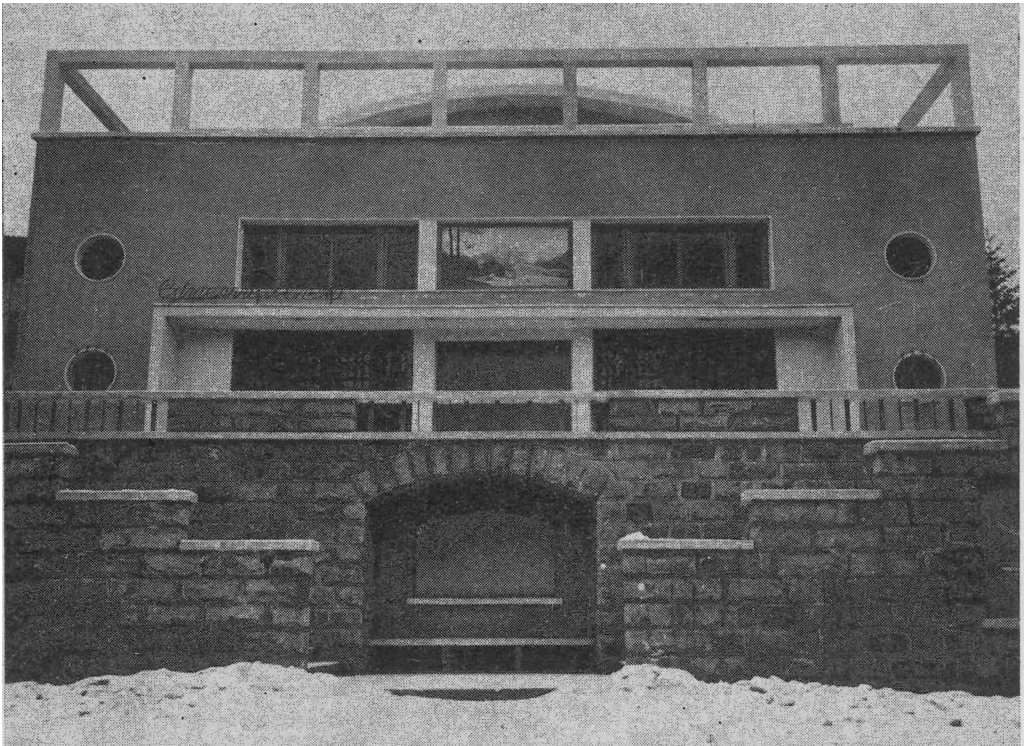
Vista esterna del “Cinema Pineta”
