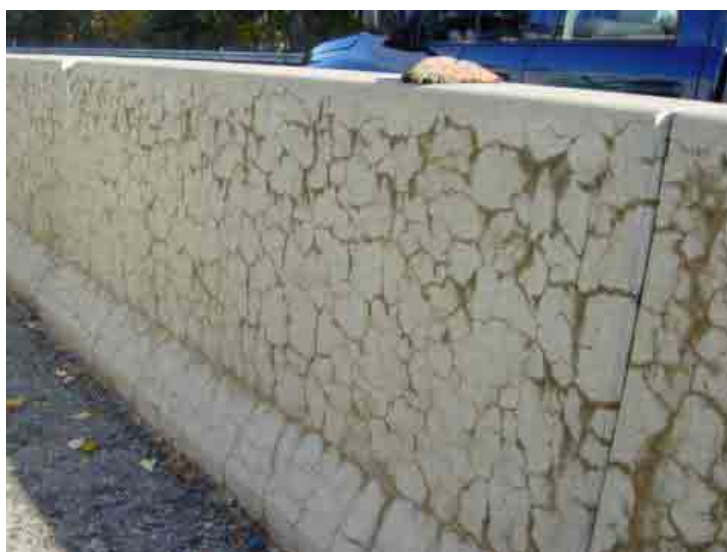
Figura 2.8: Esempio di degrado dato dalla reazione alcali-aggregati
