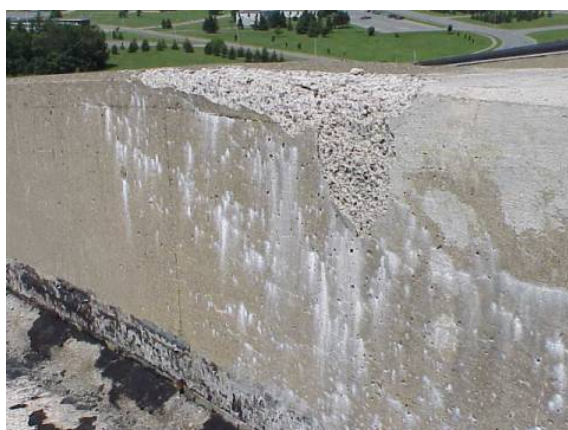
Figura 2.5: Degrado da gelo-disgelo
