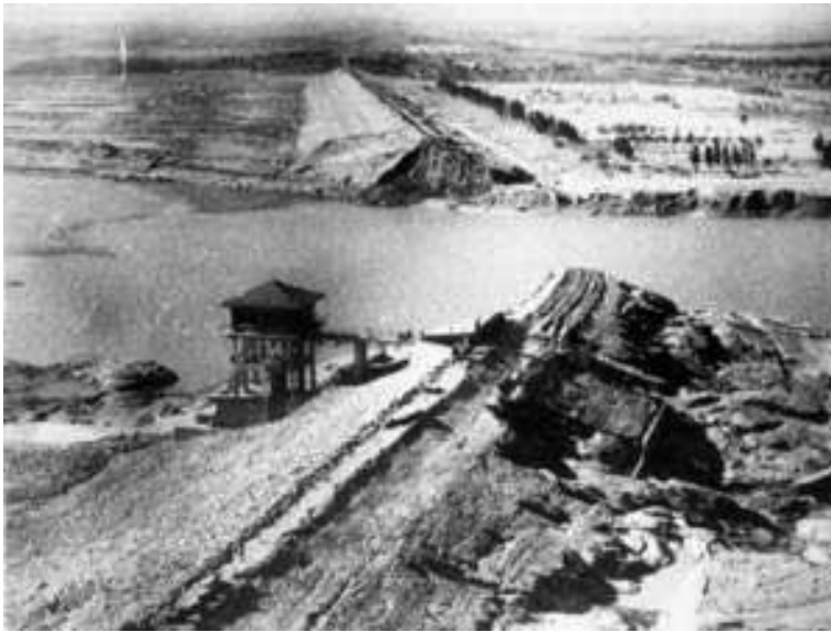
Figura 4. Crollo della diga Banqiao in Cina
