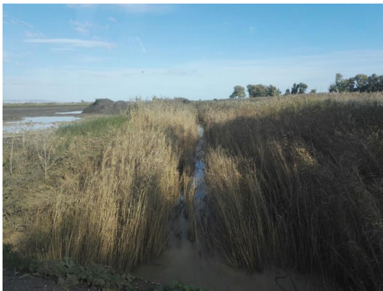
Figura 16. Stato di uno dei canali.
