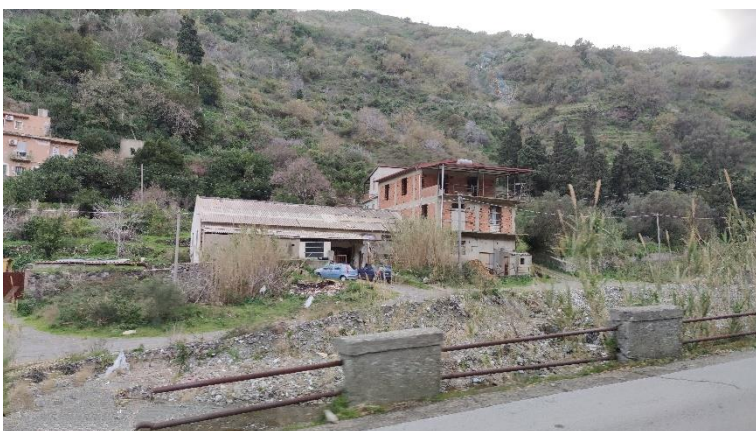
Figura 23. Abitazione costruita nell'alveo del torrente Giampileri
