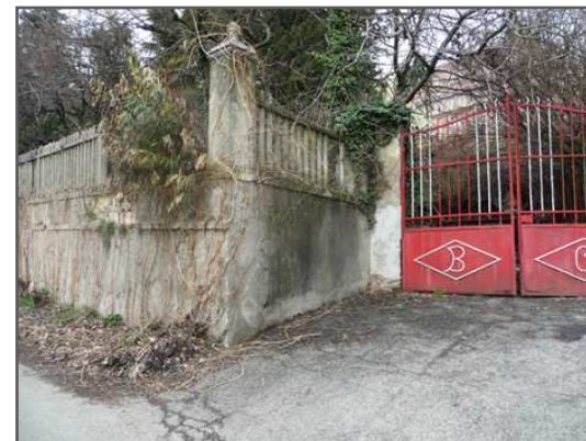
Fig. 29 Muro di sostegno giardino Castello su Via Cavalli d'Olivola
