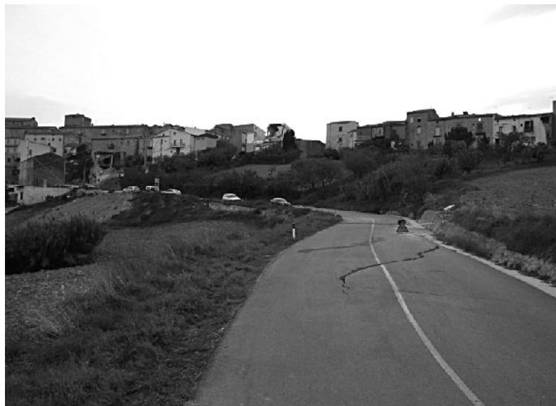
Fig.1.5. Frattura del manto stradale dovuta alla riattivazione di una frana durante il terremoto umbro-marchigiano.
