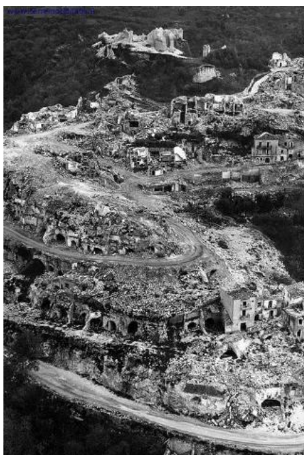
Fig.1.4. Veduta aerea del comune di Laviano completamente raso al suolo dal sisma dell'Irpinia (1980). Scatto tratto dal sito della Protezione Civile.
