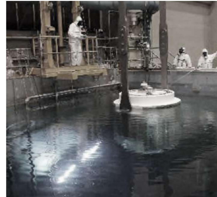
▲ Image above Il progetto di disattivazione della Centrale di Caorso e lo stato di avanzamento delle attività
