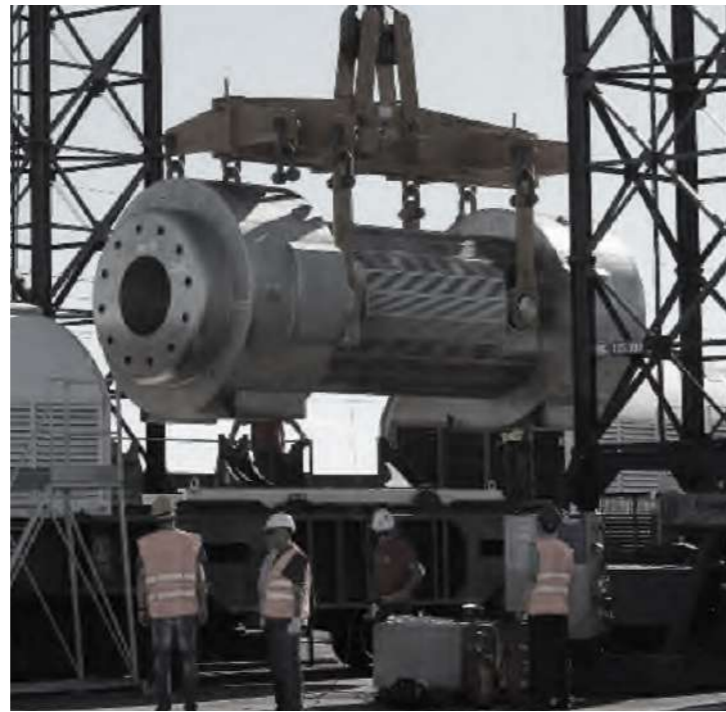
▲ Image above Il progetto di disattivazione della Centrale di Caorso e lo stato di avanzamento delle attività
