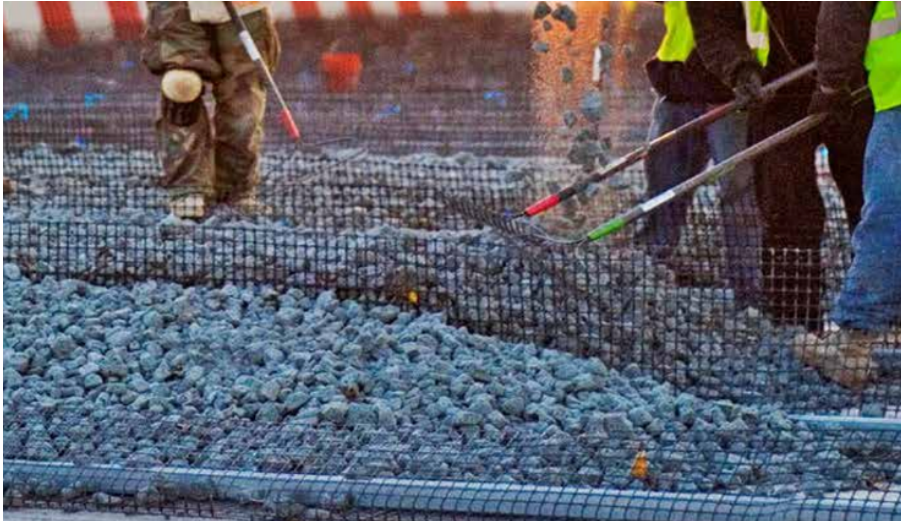
Figura 6.2: Preparazione di EMAS in schiuma di vetro
