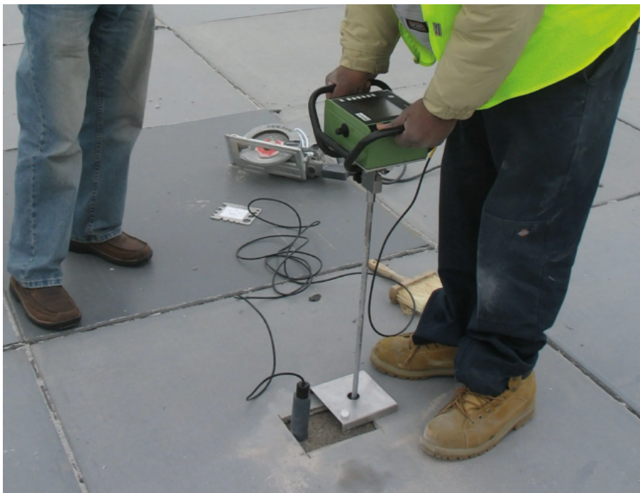
Figura 9.1: Field Strength Test in un EMAS in blocchi di calcestruzzo cellulare
