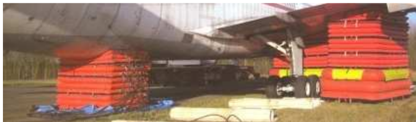
Fig. 4.10 Operazioni di sollevamento con cuscini pneumatici
