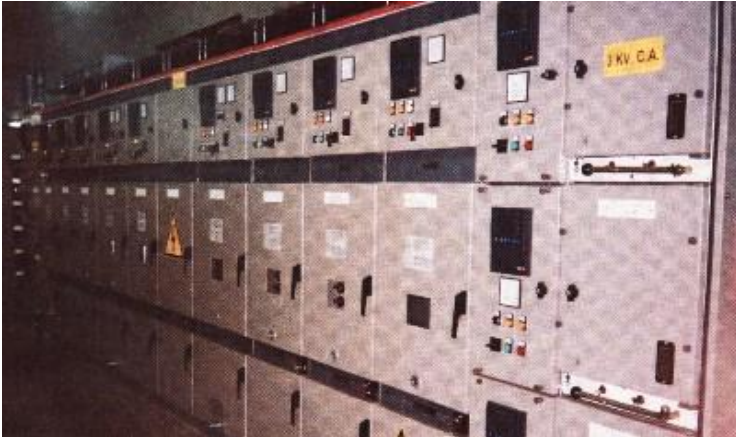
Quadro elettrico principale a bordo nave [1.3.b.]
