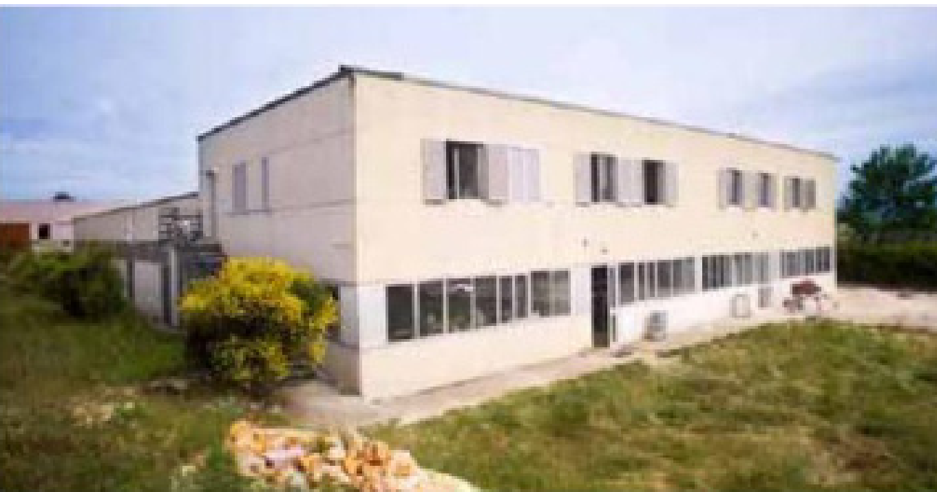
OFFICINA ZONE UMANE VISTA ESTERNA
