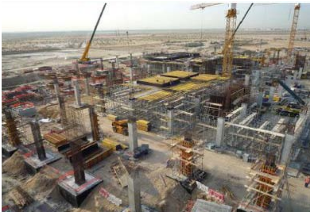
Figura 77 - Stato di avanzamento edificazione Masdar
