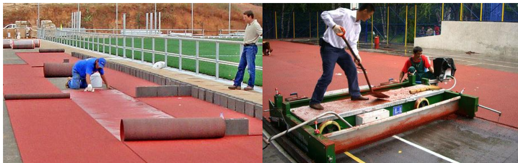
Figura 1.2: esempi di messa in posa di pavimentazioni sintetiche prefabbricate e colate
