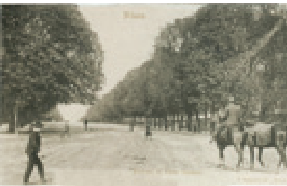
3.4.2 e 3.4.3 Pubblici passeggi, sopraelevati, lungo i Bastioni di Milano.
