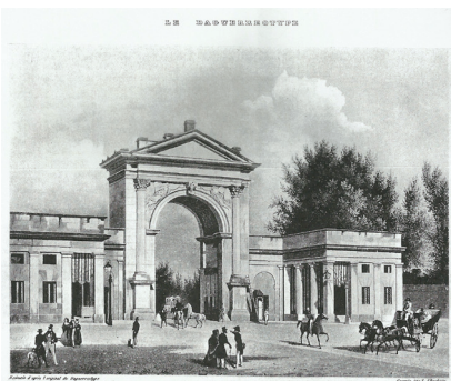
3.4.10 L'attuale Porta Nuova dello Zanoia, realizzata nel 1810
