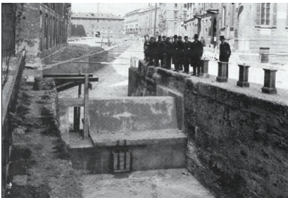
3.6.3 Tombinatura del Naviglio della Martesana lungo via Melchiorre Gioia; 3.6.4 lavori di copertura del Naviglio di San Marco nel 1930
