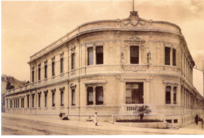
4.5.8 Fotografia d'epoca del Bagno al Ponte delle Gabelle. A fianco, 4.5.9 la pianta del primo piano.
