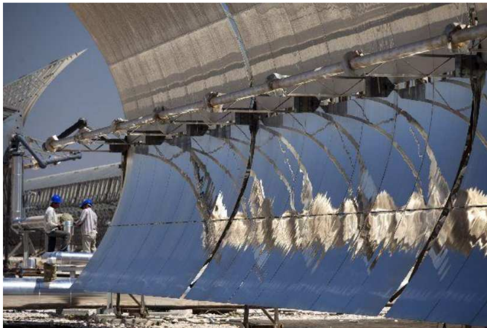
Figura 65: Dettaglio di un collettore parabolico: specchi e ricevitore
