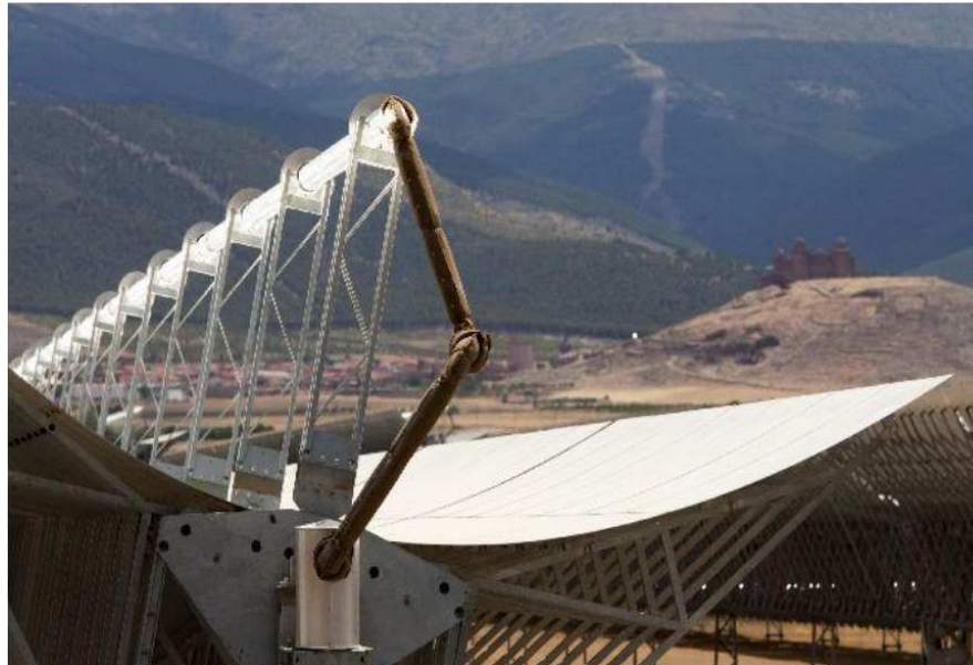
Figura 67: Dettaglio del sistema di azionamento del collettore
