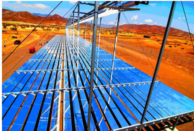
Figura 10: Collettori lineari Fresnel, Plataforma Solar de Almeria (Spagna)
