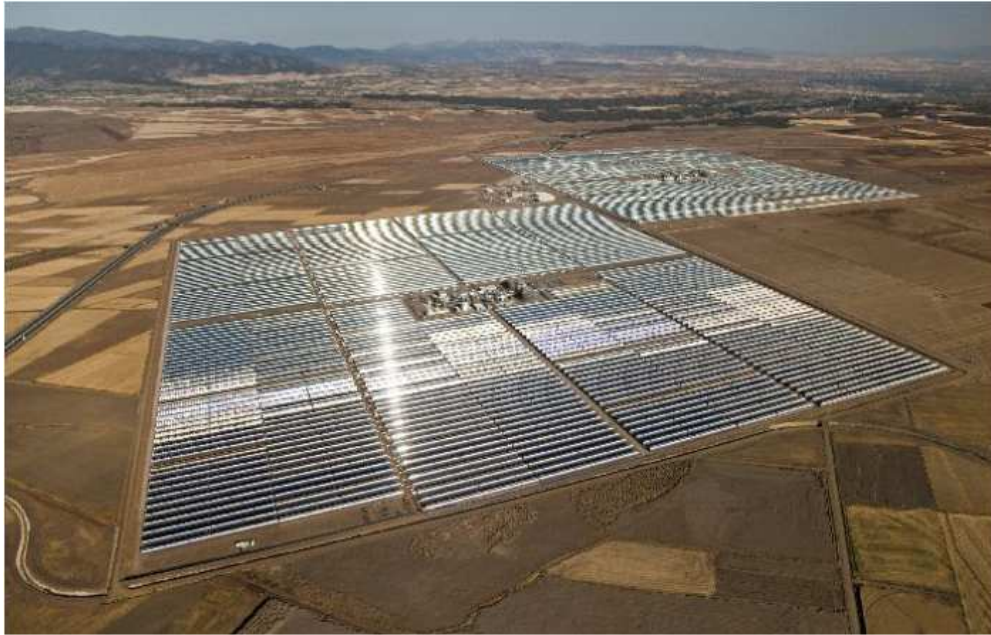
Figura 57: Vista del campo specchi di un impianto solare
