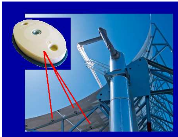
Figura 29: Elementi di fissaggio ceramici
