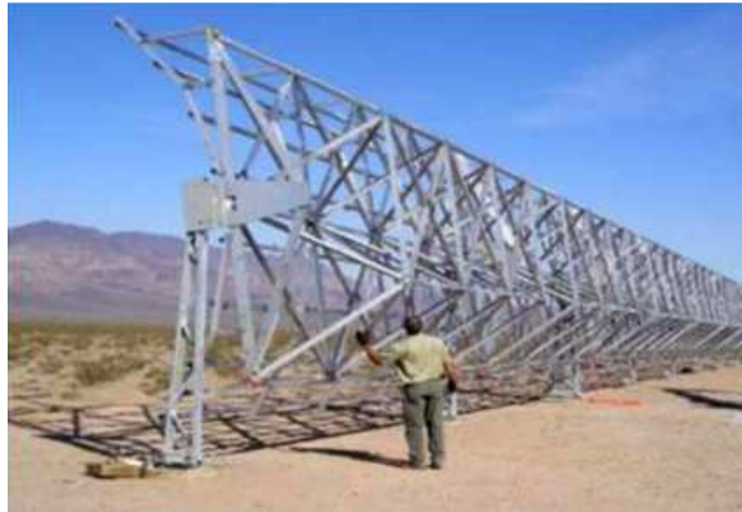
Figura 18: Collettore SGX1, Nevada Solar One (USA)
