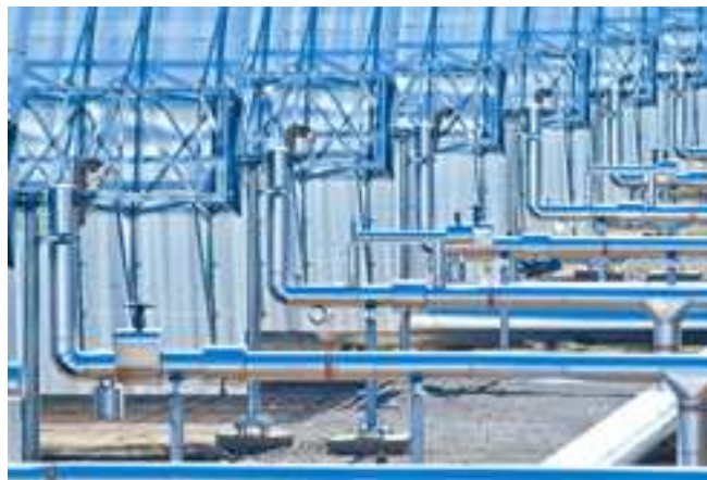
Figura 30: Piping di collegamento tra i loops e le header pipes
