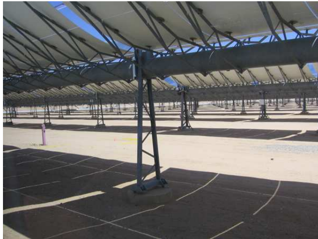
Figura 16: Collettori torque tube LS2
