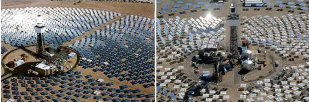
Figura 14: Sulla sinistra Solar One, sulla destra Solar two
