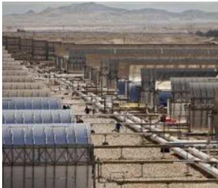
Figura 69: Vista del piping di collegamento
