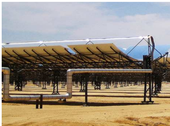
Figura 17: Collettori V-truss LS3
