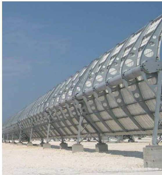
Figura 20: Collettori Enea, Impianto Archimede di Priolo (Italia)
