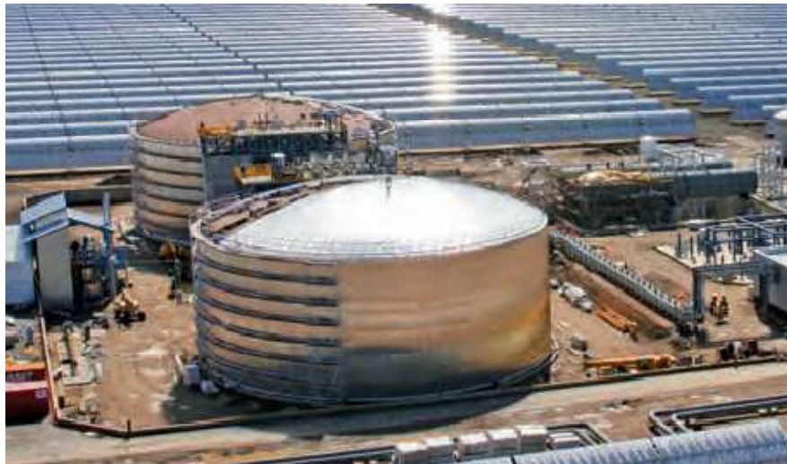
Figura 34: Serbatoi di accumulo in costruzione (Andasol I)
