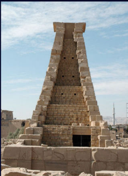
Fig. 2.59 - Resti di un pilone del tempio di Mut a Karnak con i paramenti murari esterni e gli interventi di restauro recenti
