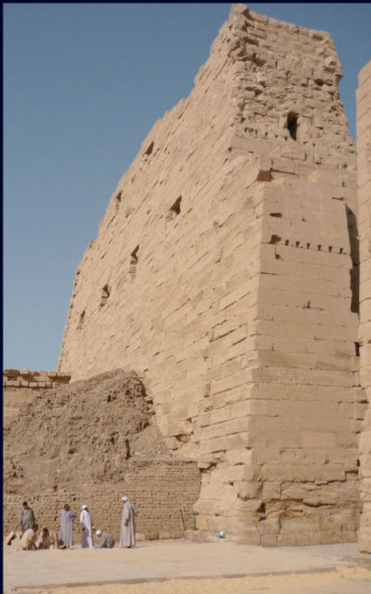
Figg. 2.64, 2.65, 2.66 - Primo pilone del tempio di Amon a Kamak con le tracce evidenti del mancato completamento. Blocchi non ancora regolarizzati si osservano su tutta la superficie, negli spigoli e in corrispondenza degli alloggi dei pennoni
