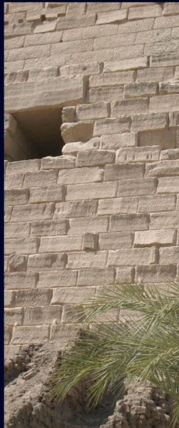
Figg. 2.64, 2.65, 2.66 - Primo pilone del tempio di Amon a Kamak con le tracce evidenti del mancato completamento. Blocchi non ancora regolarizzati si osservano su tutta la superficie, negli spigoli e in corrispondenza degli alloggi dei pennoni
