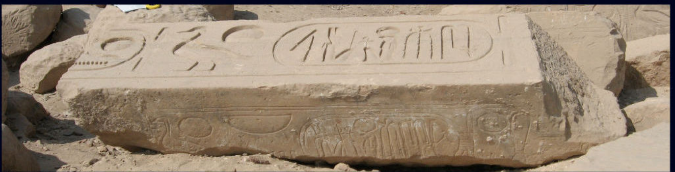
Fig. 3.87 - Architrave crollato del terrazzo
