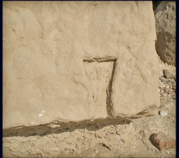
Fig. 3.103, 3.104, 3.105 - Incastri a coda di rondine nella parte superiore di elementi di coronamento della trabeazione
