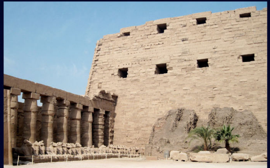
Fig. 2.60 - Primo pilone del tempio di Amon a Karnak con le tracce evidenti del mancato completamento. si osservano i blocchi di pietra agli spigoli, non ancora lavorati nella forma dei tori a sezione circolare
