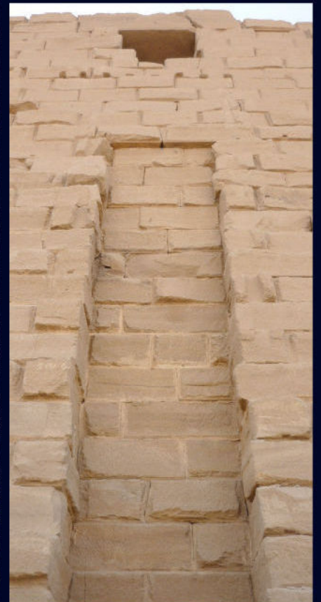
Figg. 2.64, 2.65, 2.66 - Primo pilone del tempio di Amon a Kamak con le tracce evidenti del mancato completamento. Blocchi non ancora regolarizzati si osservano su tutta la superficie, negli spigoli e in corrispondenza degli alloggi dei pennoni
