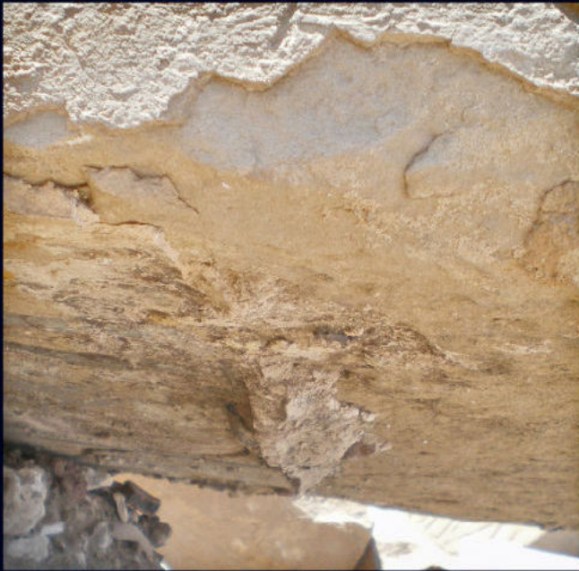
Fig. 3.102 - Resti di uno strato di rivestimento su un arcuitrave. E' evidente la continuazione sul dado
