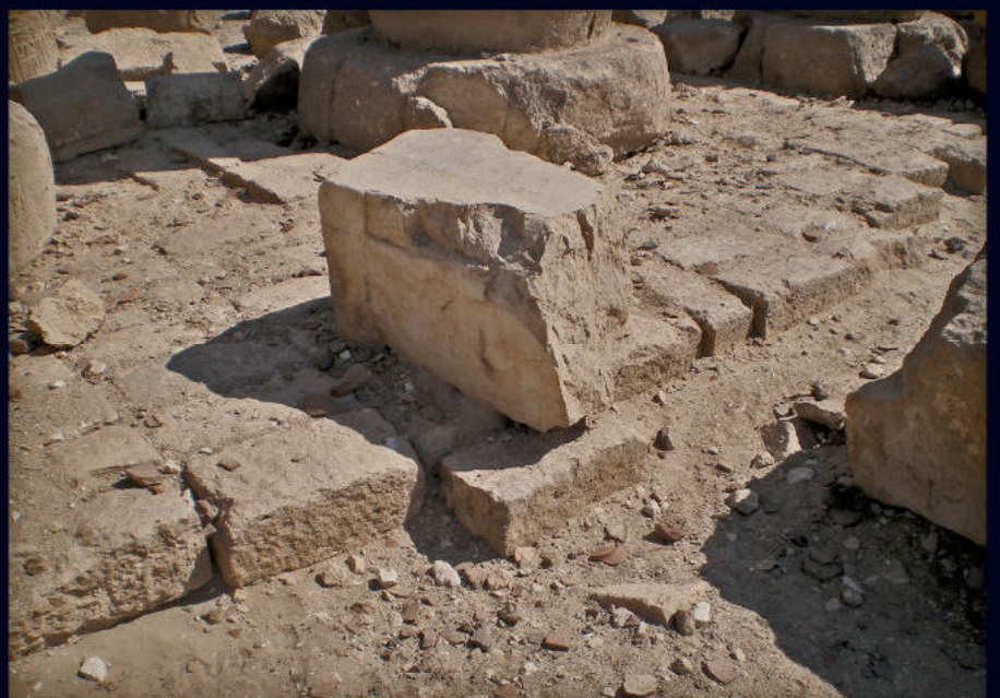
Fig. 3.76 - Pavimentazione del piano stilobate sul fronte tra le colonne 8 e 9
