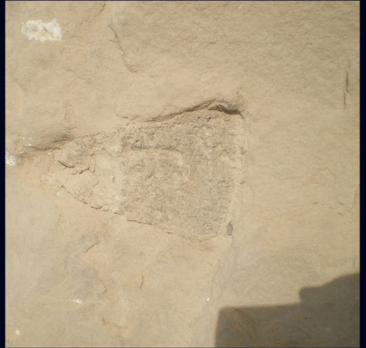
Fig. 3.103, 3.104, 3.105 - Incastri a coda di rondine nella parte superiore di elementi di coronamento della trabeazione
