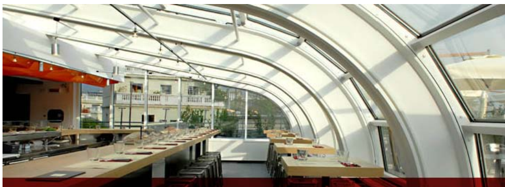
Fig. 163 Interno - zona coperti c/o La Rinascente, Milano
