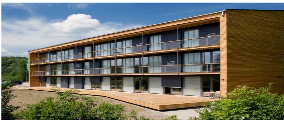
Fig. 224 Sede principale di Zurigo - edificio impatto zero
