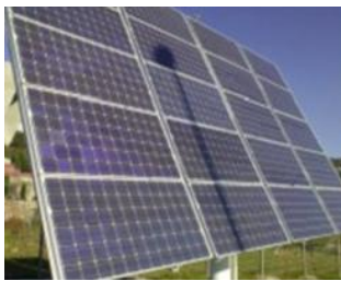
fig. 4.1 - Esempio di un impianto da 2kW con un'ombra incidente (a sinistra) e curva potenza-tempo (a destra) in cui si nota la perdita legata all'ombra
