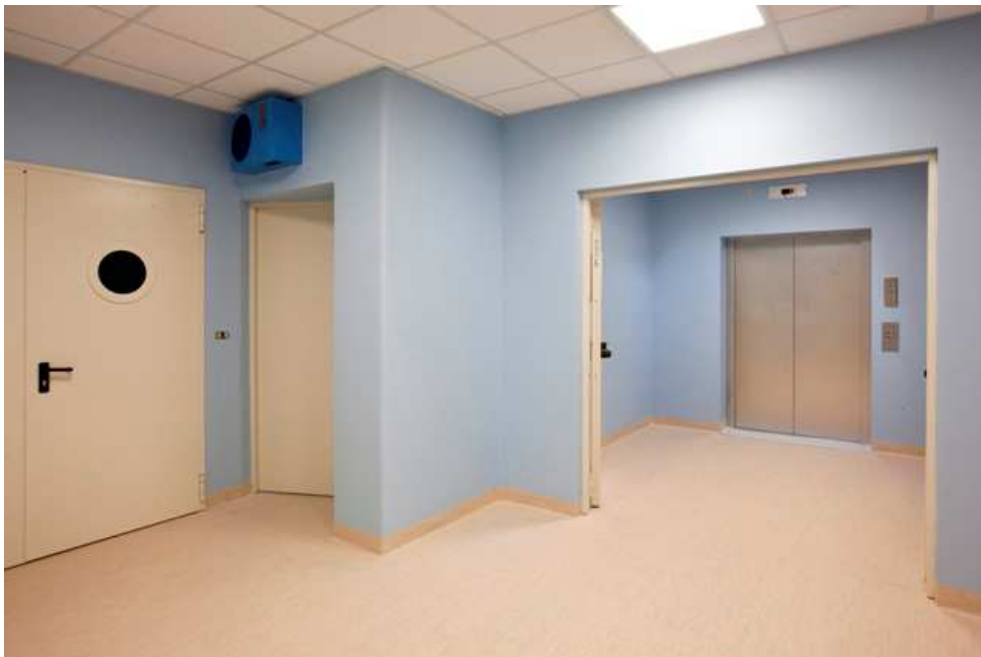
Vista del rivestimento in PVC della pavimentazione. (Fonte: Infrastrutture Lombarde S.p.A.)
