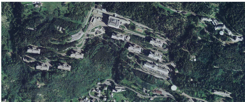
Vista del complesso ospedaliero con la Strada Statale di accesso all'ospedale e la Via Zubiani. (Fonte: Infrastrutture Lombarde S.p.A.)
