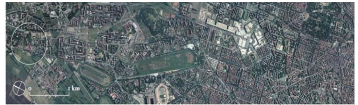
Figura 2. Complesso residenziale Monte Amiata del Gallaratese, 1967/74
