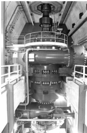
Figura 16 - Una pompa-turbina
