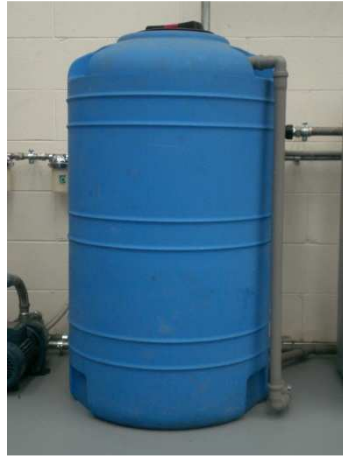
Figura 1. 12 Serbatoio raccolta acqua
