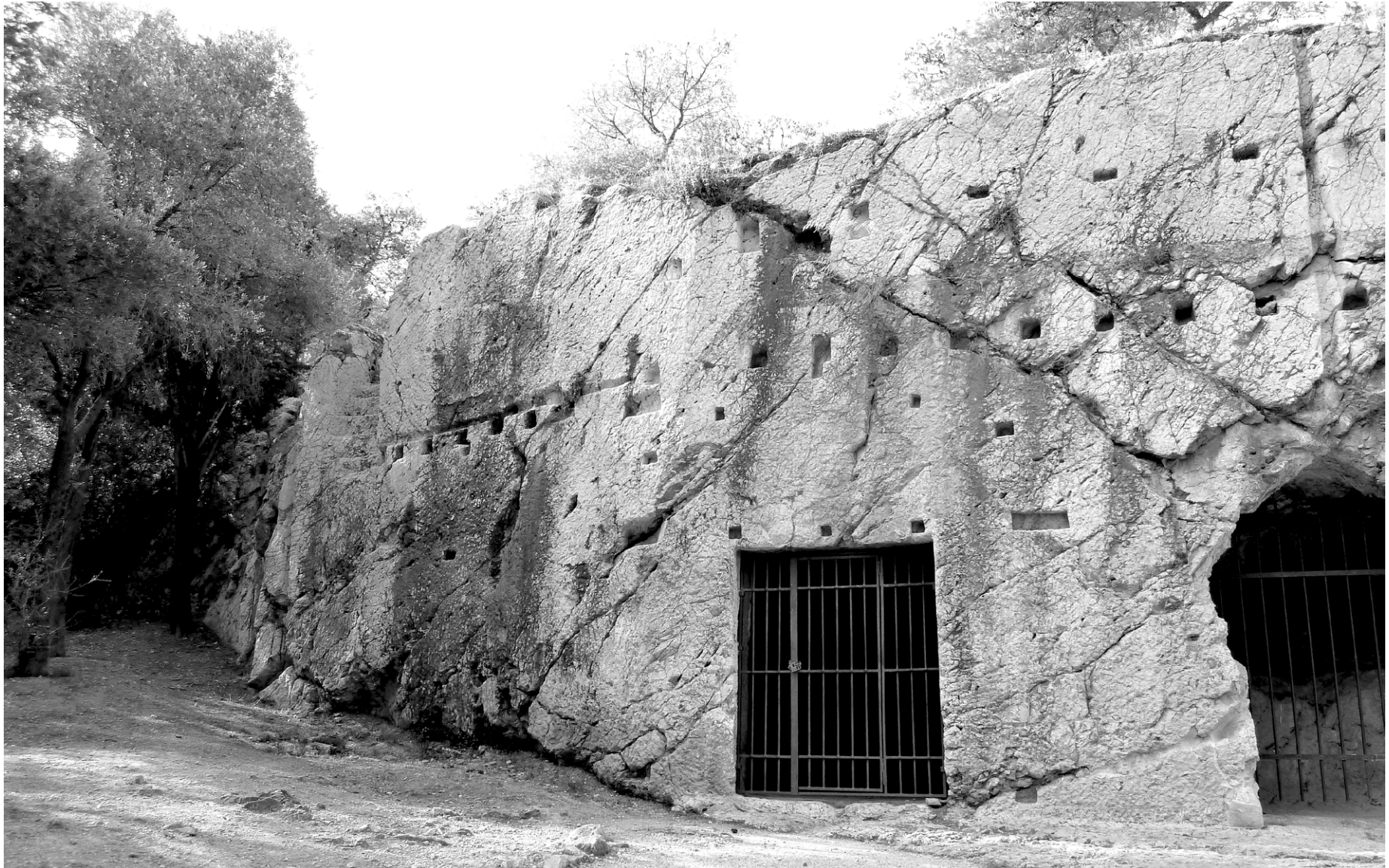
I fori dove si presume alloggiassero le travi che reggevano il secondo piano dell'edificio
