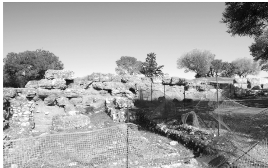
Scarsa attenzione alla conservazione ed esposizione dei ruderi
