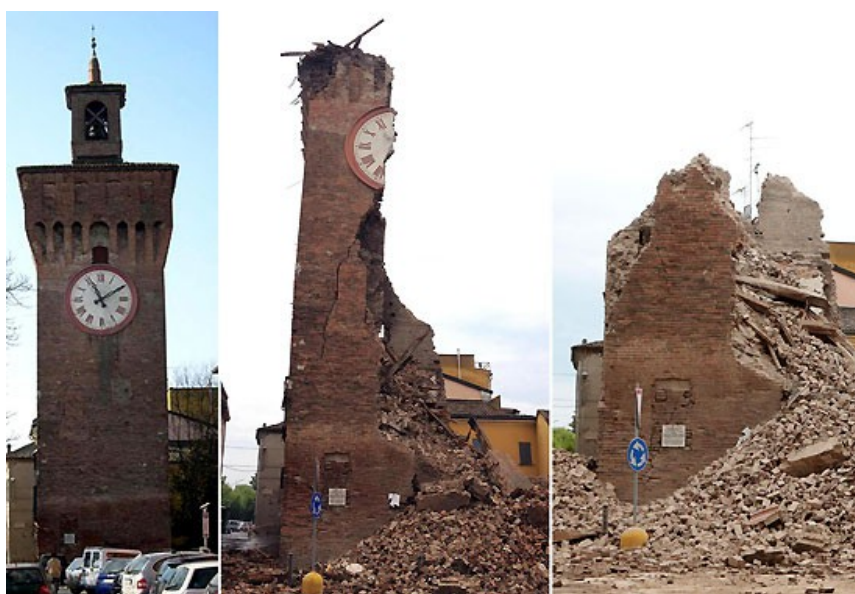
Illustrazione 1.4: Sequenza del crollo totale della Torre dei Modenesi a seguito dell'evento sismico del 20 Maggio 2012.
