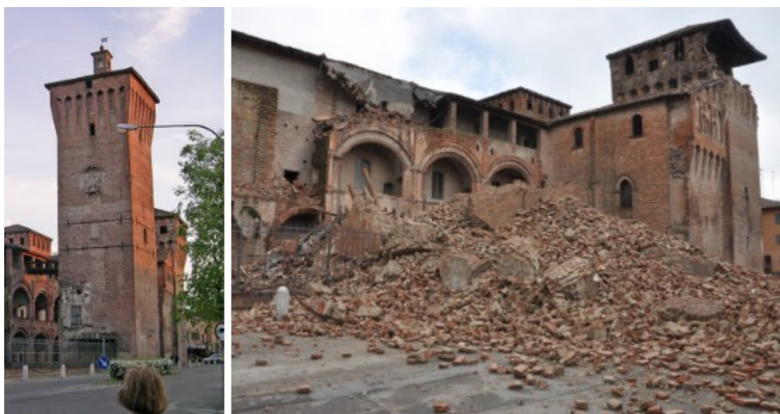
Illustrazione 1.5: Mastio del Castello delle Rocche prima e dopo il sisma.
