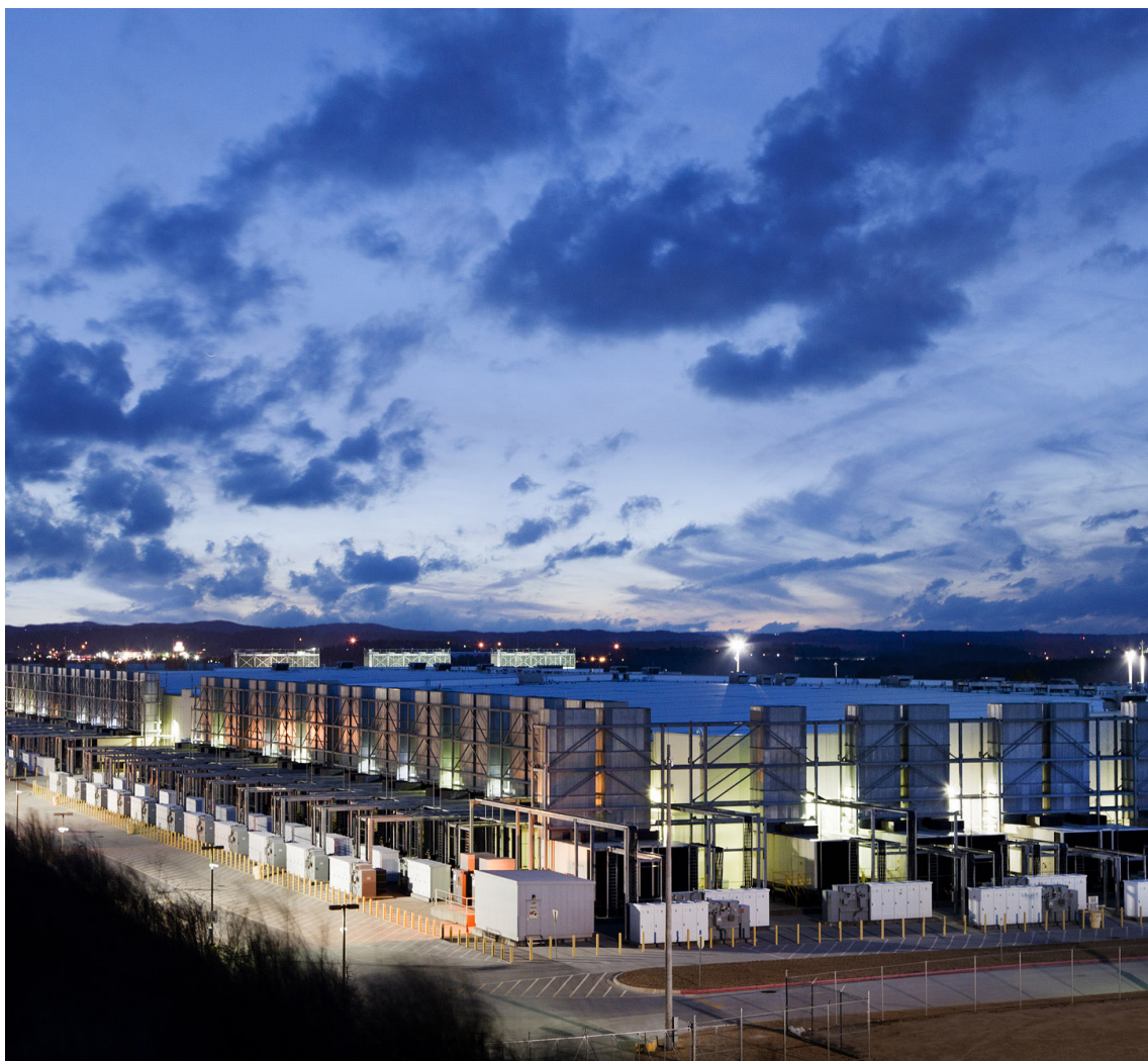
fig. 40 Struttura totale del Google Data Center "The Dallas", Oregon, US.
