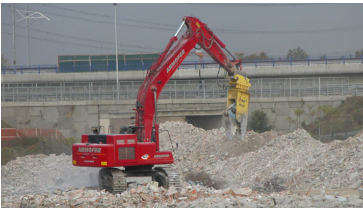
[37] Intervento di frantumazione del calcestruzzo per il riciclaggio da parte della ditta Armofer, 2009.
