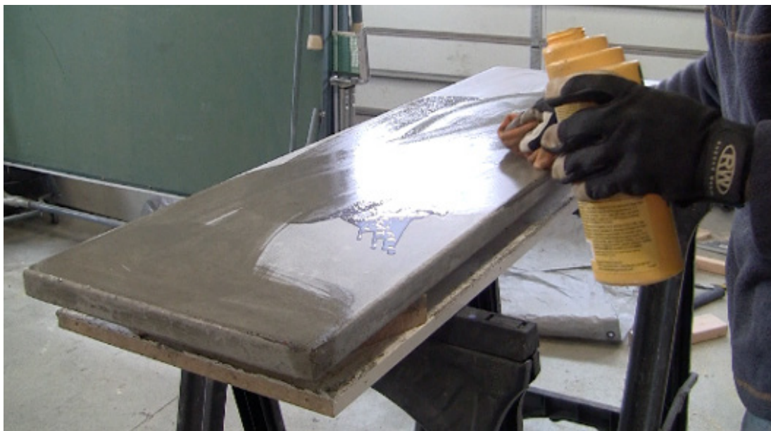
[45] Applicazione di un prodotto a base di cera su una lastra in calcestruzzo.
