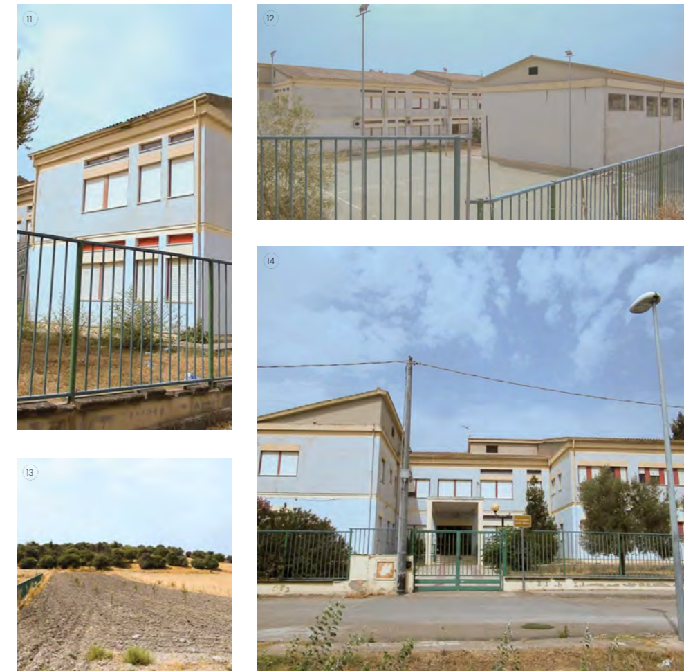
Figura 17.11: Fronte Nord edificio scolastico esistente, corpo aule su due piani. Fonte: Autori, 12/08/2021.
