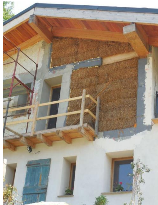
Figura 2.14: Primo strato di balle, sollevato dal terreno con un cordolo in legno (sx) e applicazione intonaco di calce e sabbia (dx)
