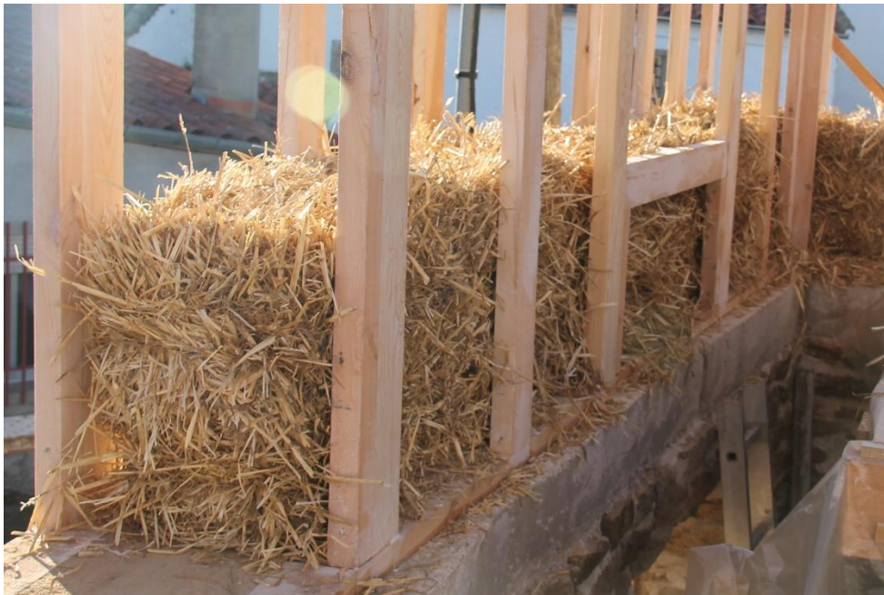
Figura 2.6: Sistema costruttivo GREB
