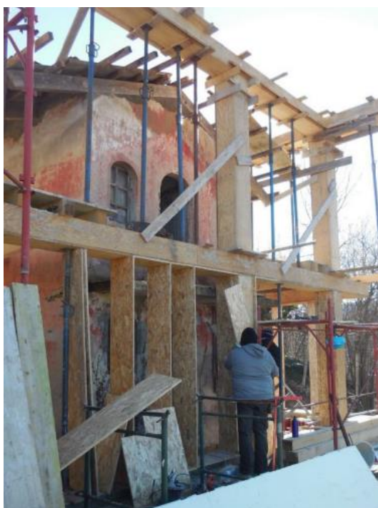
Figura 2.15: Ciabòt interno e struttura portante ricoperta da pannelli di compensato (sx) e tamponamenti esterni in paglia compressa (dx)
