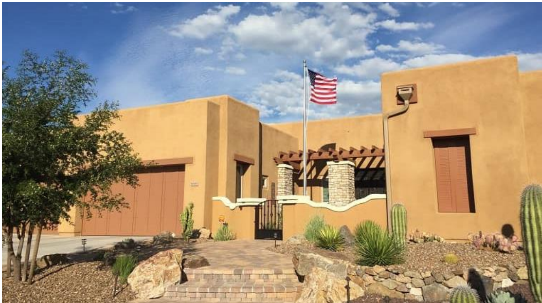
Figura 2.11: Casa realizzata in adobe
