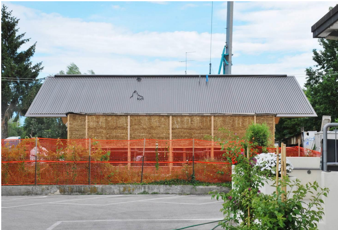
Figura 2.17: Tamponamenti esterni in paglia compressa
