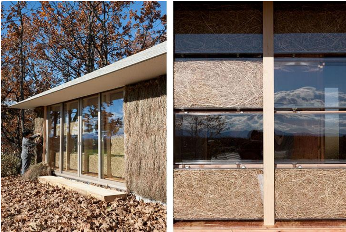
Figura 2.25: Dettaglio partizione esterna in balle di paglia
