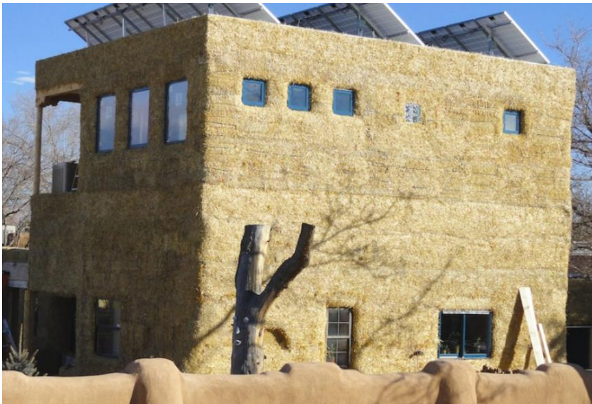
Figura 2.38: Rivestimento in paglia per l'intero edificio
