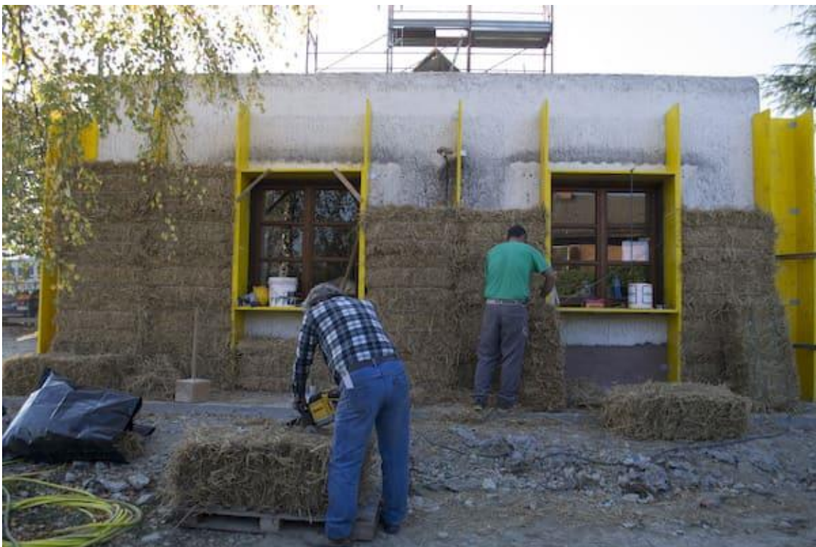
Figura 2.47: Posizionamento cappotto in balle di paglia
