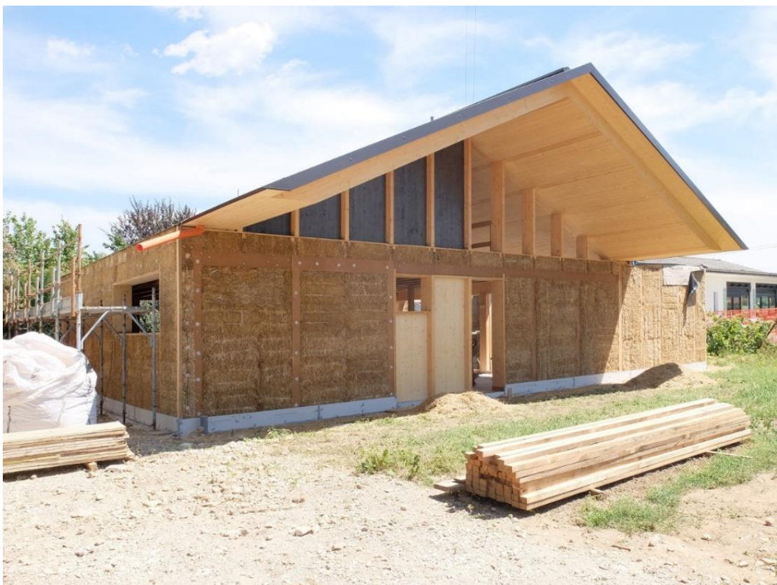
Figura 2.18: Struttura portante in legno con partizioni in balle di paglia compressa
