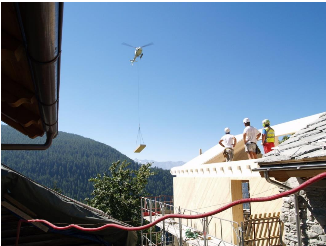
Figura 2.32: Trasporto pannelli prefabbricati
