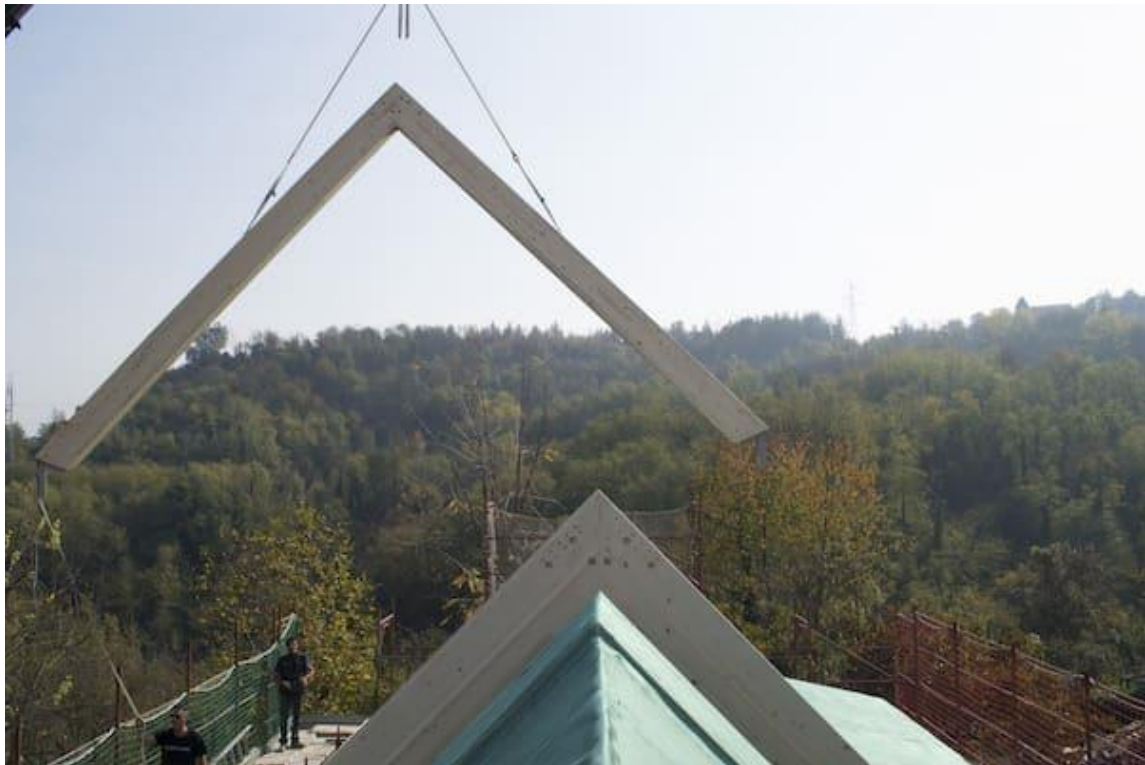
Figura 2.46: Posizionamento pannelli copertura
