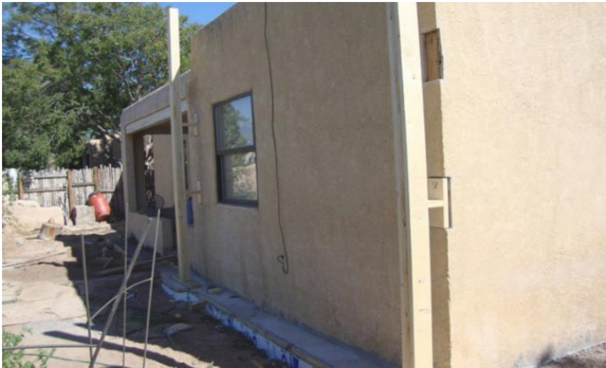
Figura 2.37: Dettaglio pilastri aggiuntivi per sostenere il secondo piano
