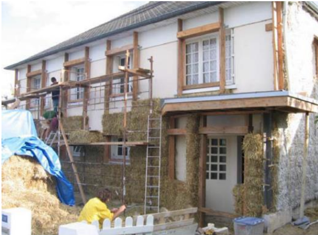
Figura 2.40: Posizionamento balle di paglia nel telaio in legno
