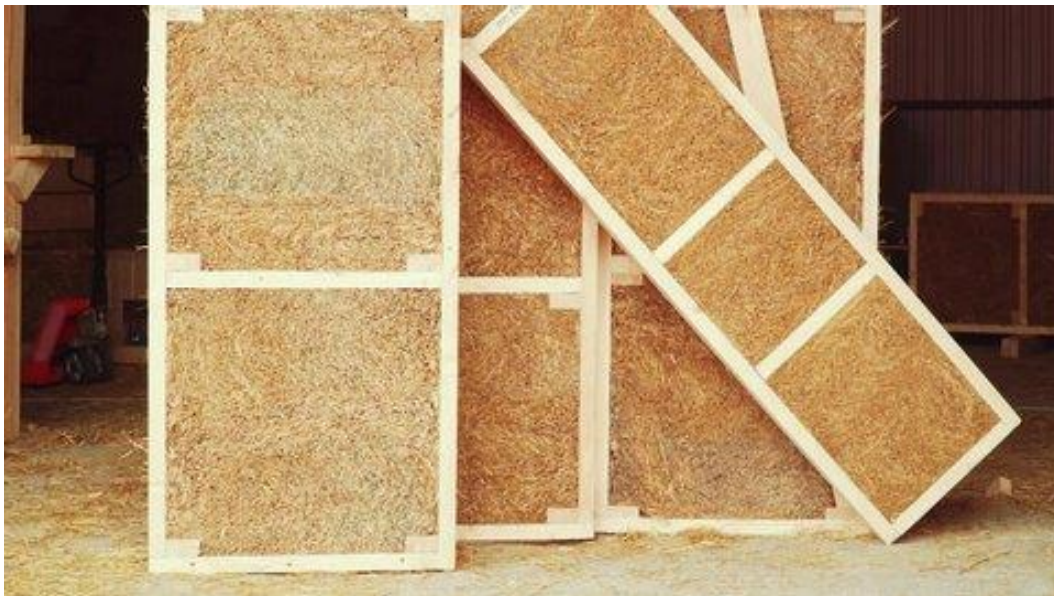
Figura 2.7: Sistema costruttivo a cassoni
