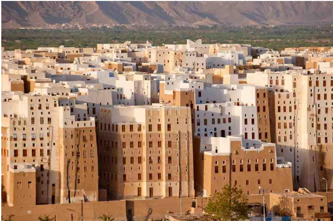
Figura 2.12: Casa realizzata in adobe
