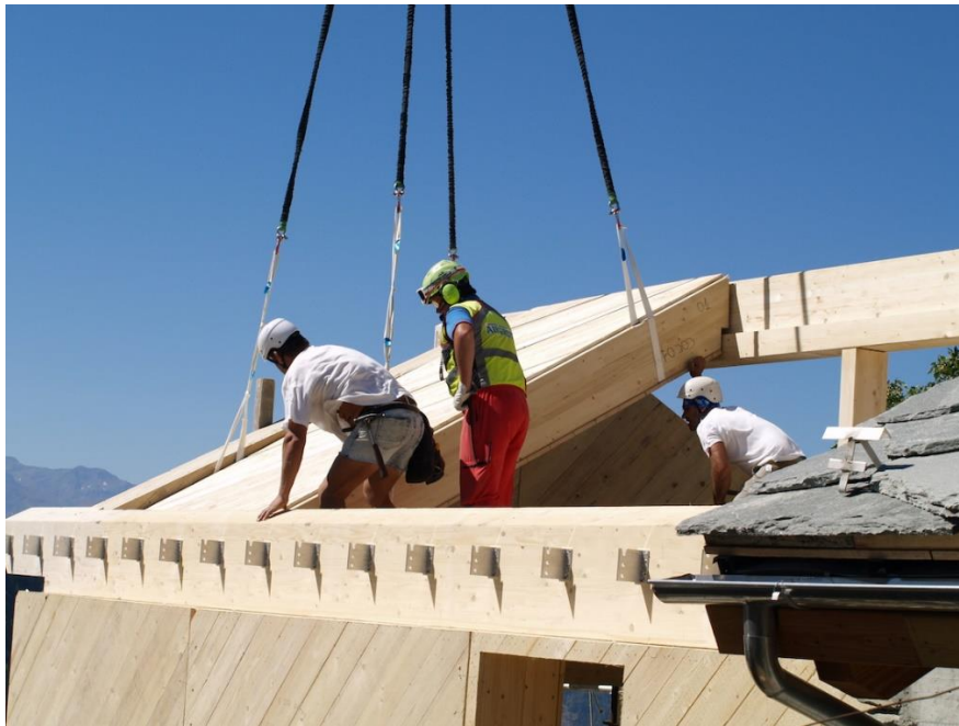
Figura 2.33: Fase di montaggio dei pannelli prefabbricati
