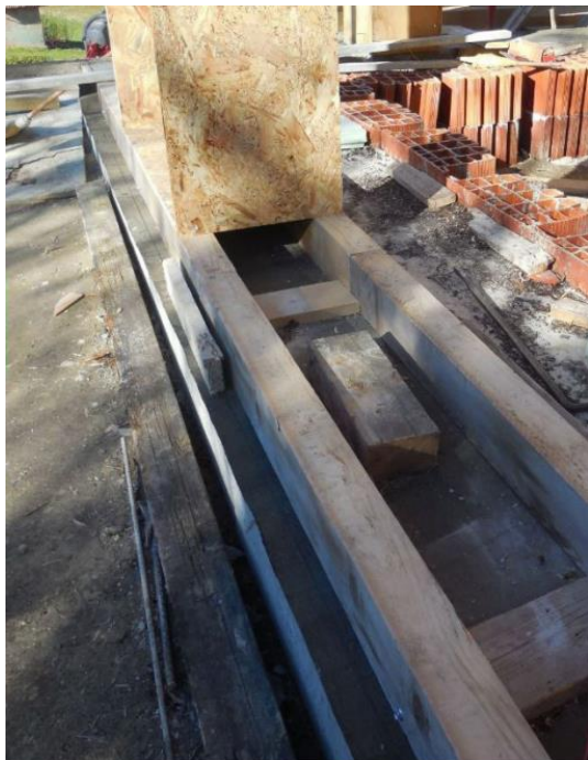
Figura 2.14: Primo strato di balle, sollevato dal terreno con un cordolo in legno (sx) e applicazione intonaco di calce e sabbia (dx)
