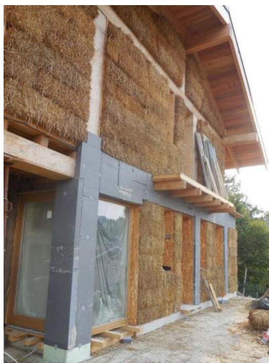
Figura 2.15: Ciabòt interno e struttura portante ricoperta da pannelli di compensato (sx) e tamponamenti esterni in paglia compressa (dx)
