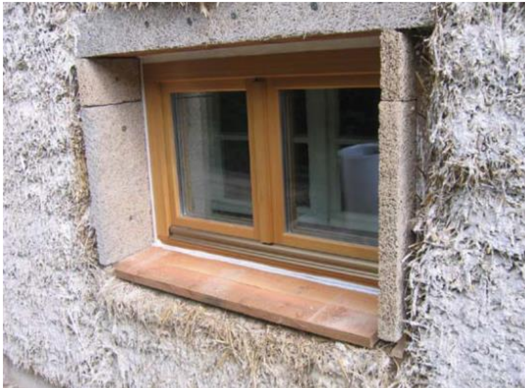
Figura 2.41: Dettaglio pannelli di Celenit attorno alle finestre con intonaco di calce posato sulla paglia
