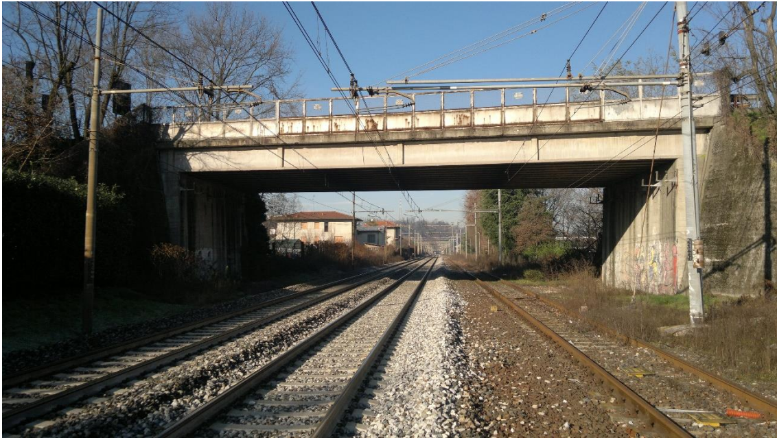
Figura 19 - Vista da sotto del ponte
