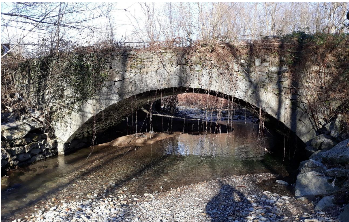
Figura 23 - Vista da sotto del ponte, lato Est
