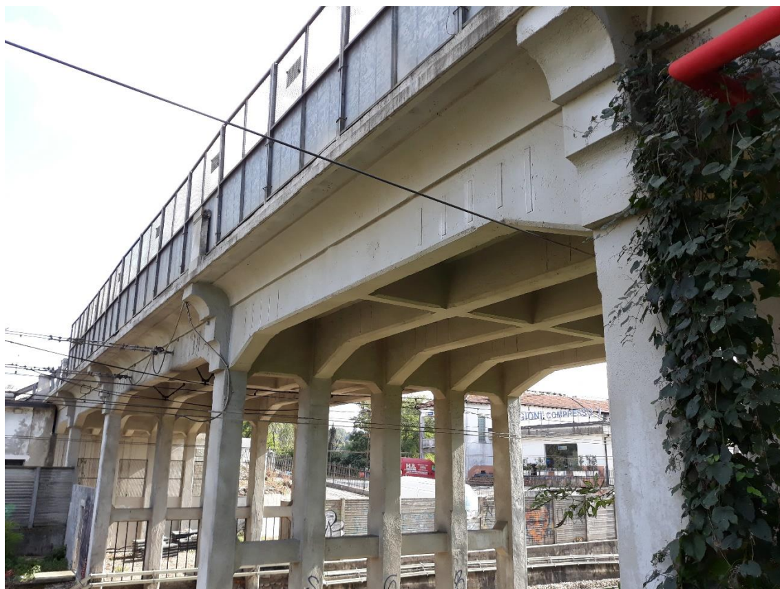
Figura 40 - Ponte in località Cantù - Asnago
