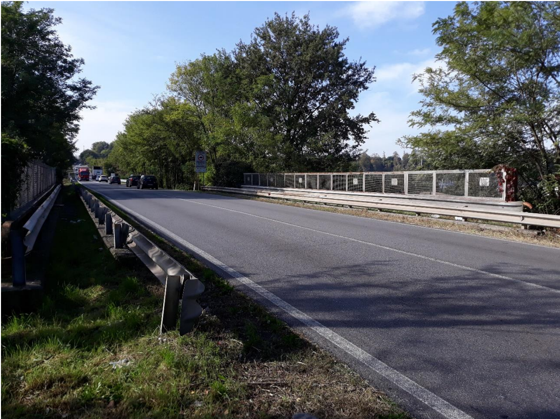
Figura 20 - Vista da sopra del ponte
