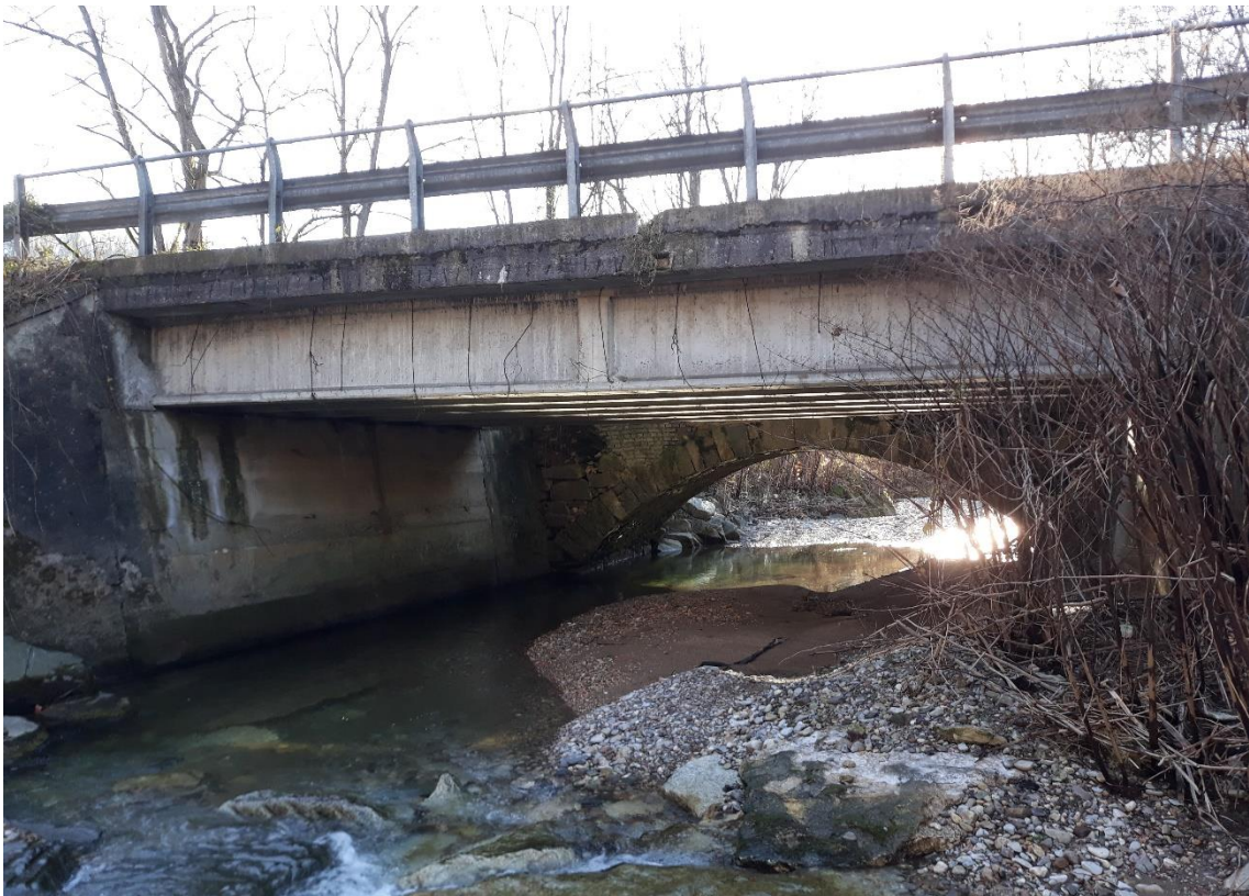
Figura 22 - Vista da sotto del ponte, lato Ovest
