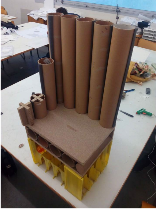
Figura 38 - Modellino ricostruito della tecnologia utilizzata nella Paper Log House.
