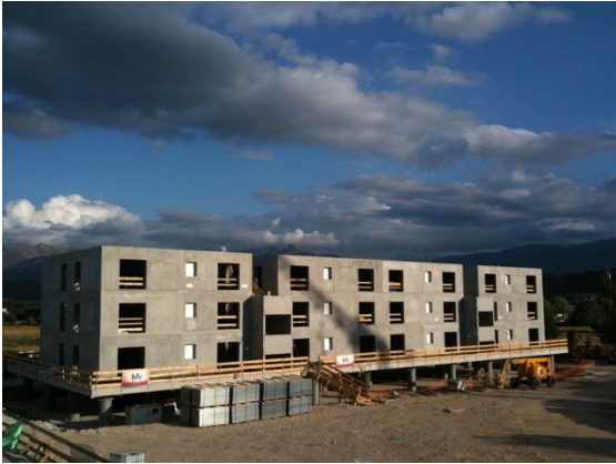
Figura 25 - Immagine fase di costruzione Impresa Pellegrini. 52
