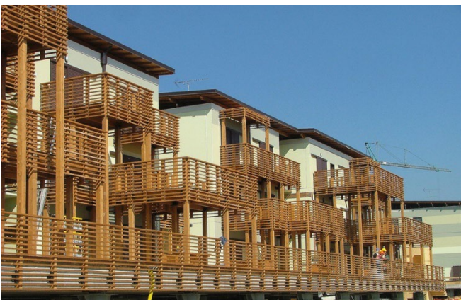
Figura 27 - Immagine fase di costruzione Impresa Pellegrini. 54
