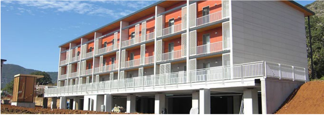
Figura 22 – Vista sull’edificio di Consorzio Stabile Arcale ultimato. 48
