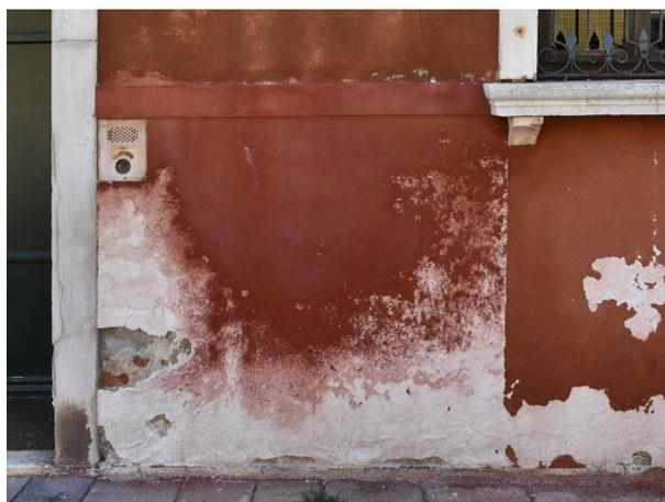
*Fig. 36; 37; 38 - Venezia. Luglio 2020. Coloritura eccessivamente satura. Distacchi e lacune dell'intonaco. Pitture pellicolanti.*
