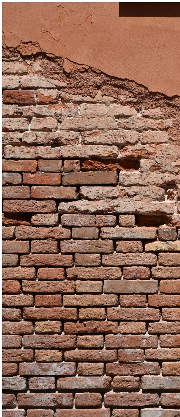
Fig. 61 - Venezia. Luglio 2020. Erosione dei giunti di malta
