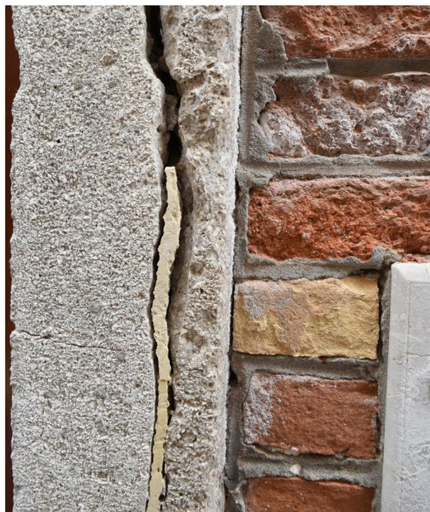
Fig. 81 - Venezia. Dorsoduro. Luglio 2020. Integrazione incompatibile di elemento lapideo con schiuma poliuretatica
