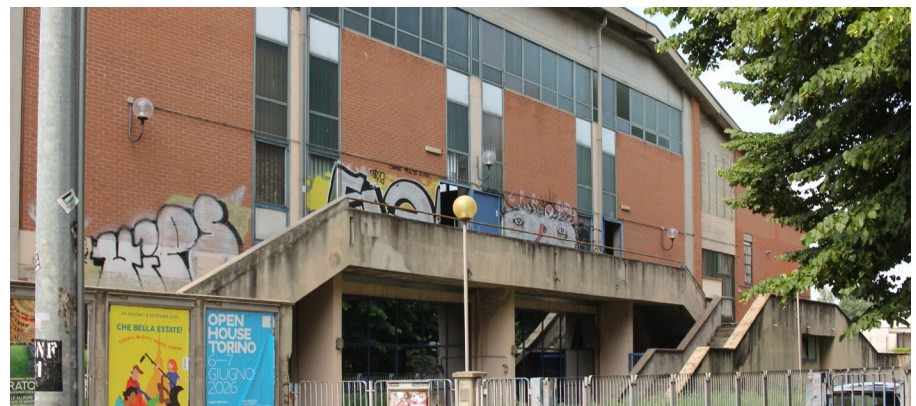
34. Vista esterna dell'edificio da Via Antonio Cecchi
