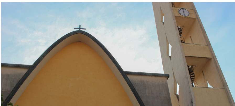
95. Vista dell'edificio. Prospetto frontale e campanile
