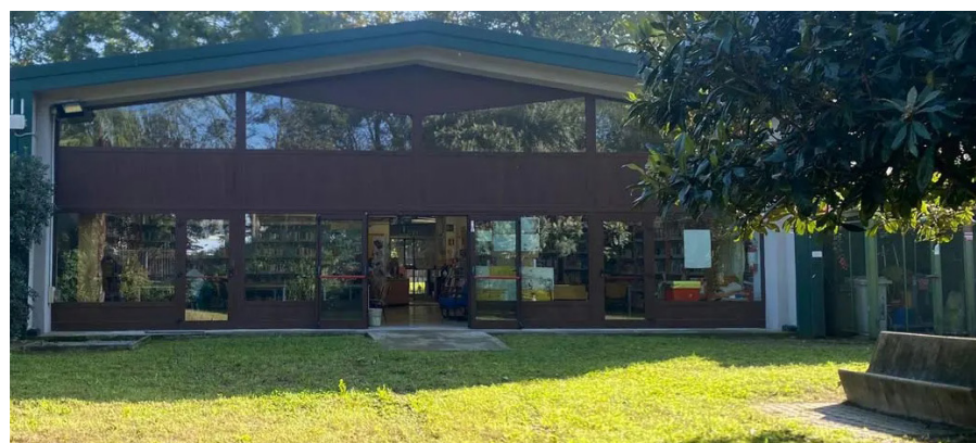
74. Prospetto della Biblioteca Lorenteggio che si affaccia sullo spazio verde
