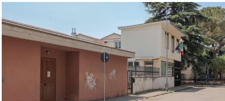
114. Vista del complesso edilizio, l'accesso alla palestra è indipendente e affacciato sulla stessa via di ingresso alla scuola
