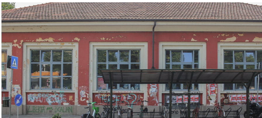
31. Vista esterna dell'edificio da Via Antonio Cecchi
