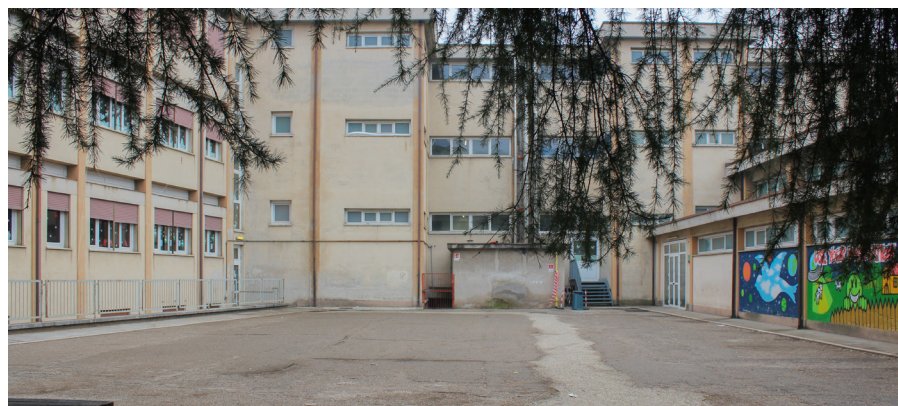
89. Cortile interno della scuola su cui si affaccia la palestra
