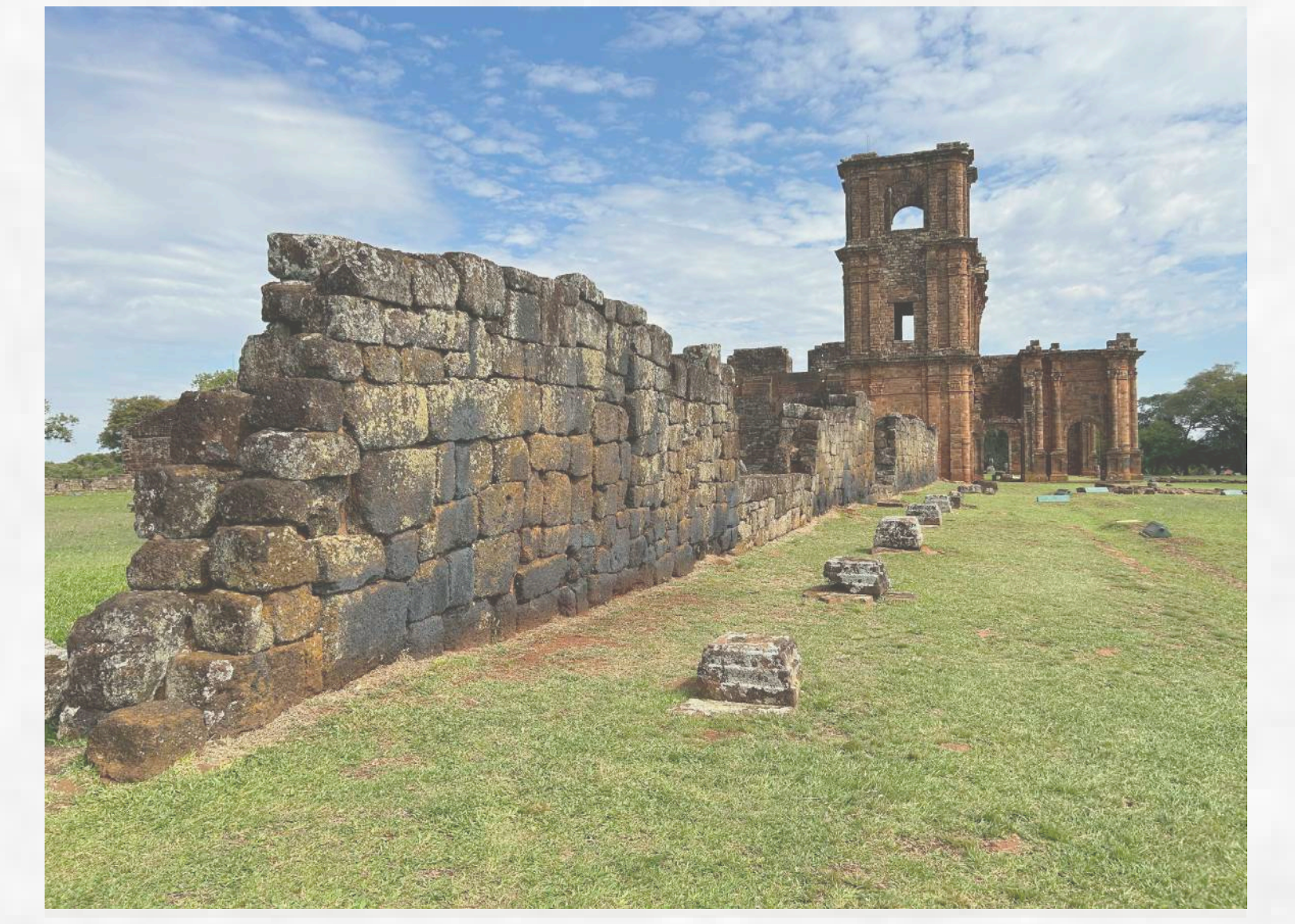
Muro in pietra itacuru e resti degli appoggi delle verande. In fondo, la torre
