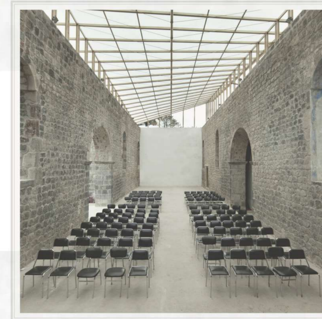
Chiesa di Baños Progetto: BROWNMENESES (2010) Localizzazione: Baños, Ecuador
