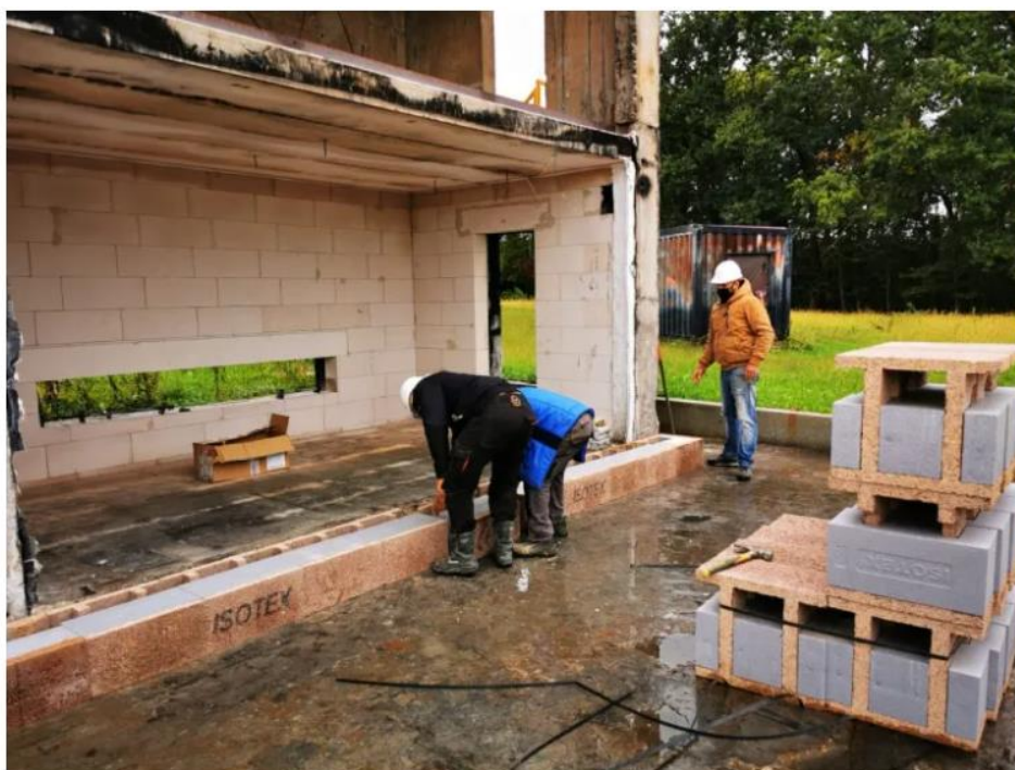
Figura 2.11 - Durante la costruzione dell'edificio oggetto di studio
