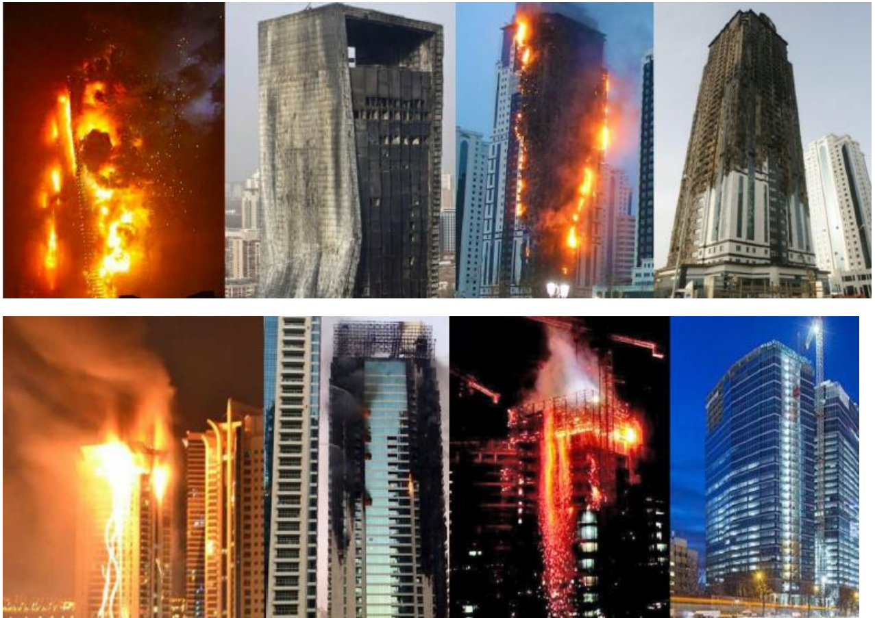
Figura 4.1 - Esempi di incendio
