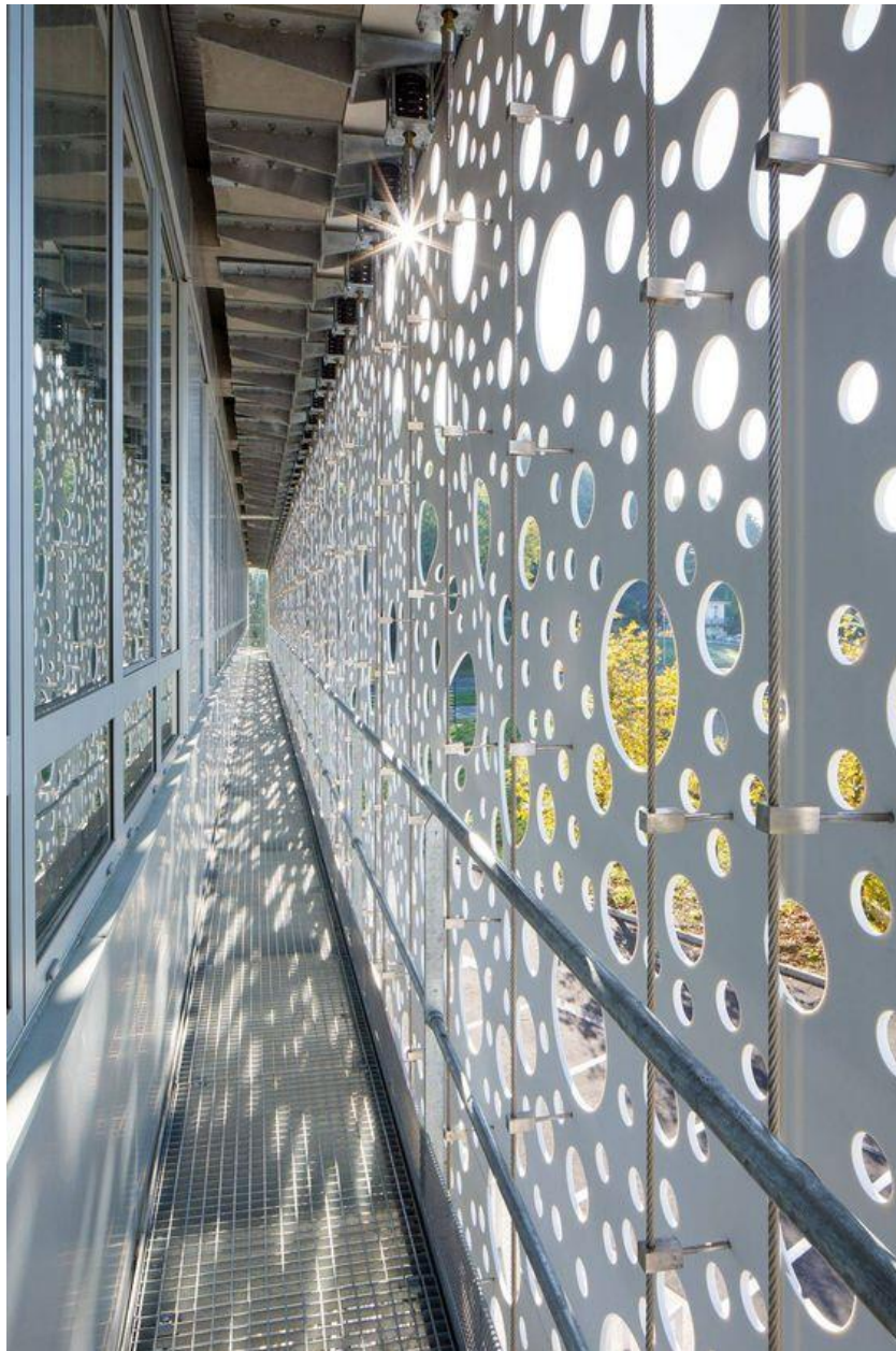
Figura 1.7 - Facciata ispezionabile con pelle esterna aperta
