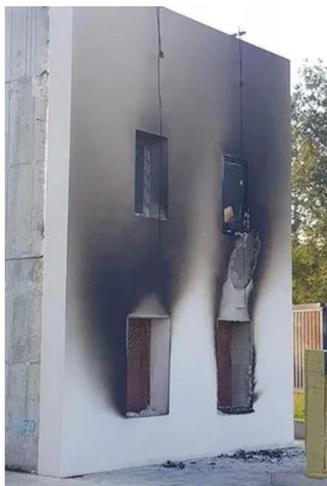
Figura 2.13 - Al termine della prova
