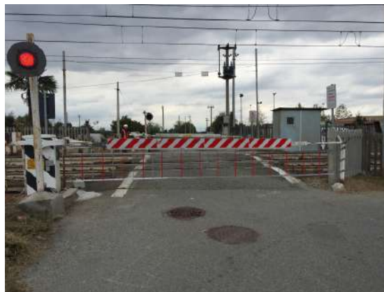
Figura 6.20: Esempio di un grembiale per pedoni e ciclisti
