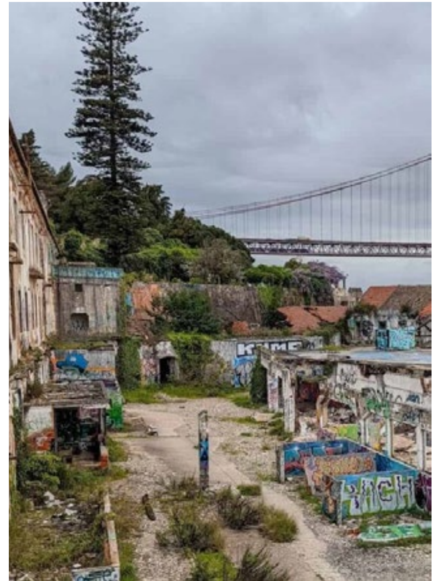
Edifici industriali abbandonati prima delle demolizioni
