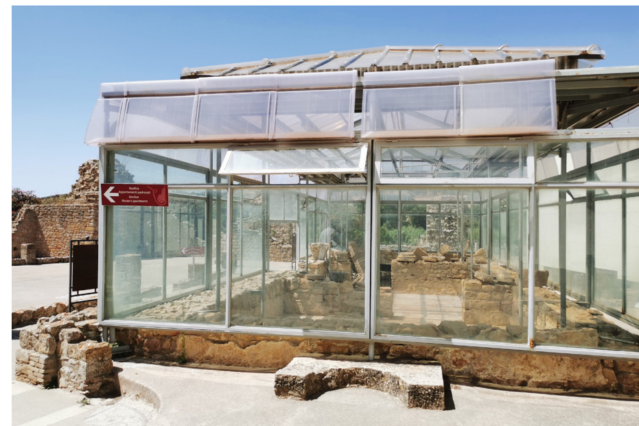
131 Vista esterna del sistema di copertura di F. Minissi sugli ambienti adiacenti al peristilio ovoidale
