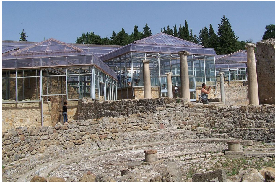
130 Vista dell'Edicola di Venere e del Tablino con l'imvolucro di F. Minissi. In primo piano si vede la grande latrina
