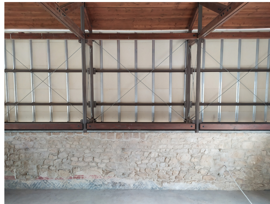
Vista interna del sistema di chiusura parietale adottato da G. Meli
