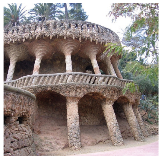
■ Fig. 5.4.f Parc Güell: the Laundry Room Portico.
