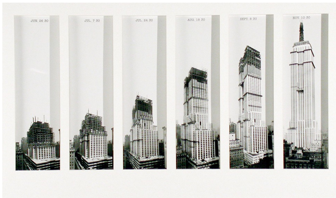
Figura 21: Fasi costruttive dell'Empire State Building
