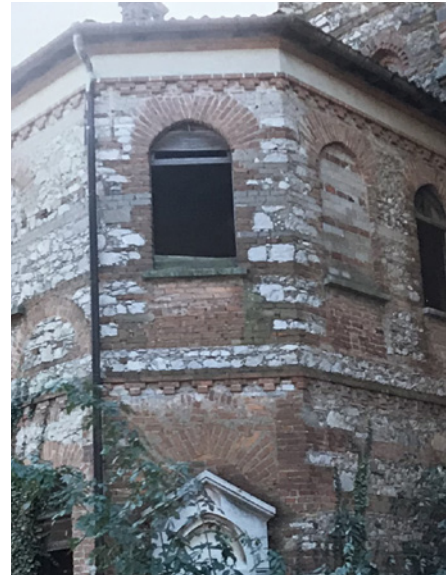
Figura 3.18: Particolare del corpo accessorio esposto a nord, foto dell'Arch. Paolo Gatti, 1994
