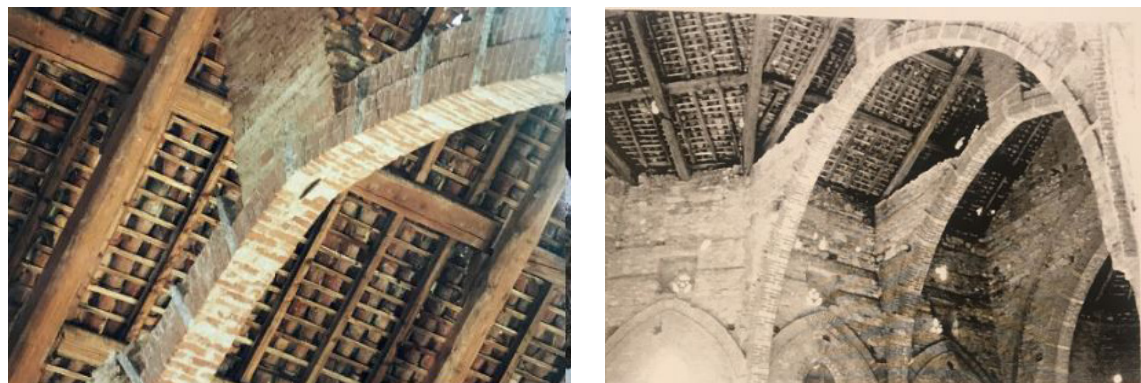
Figura 3.33-3.34 : l'intelaiatura e il tirante, foto dell'Arch. Paolo Gatti 1994 la copertura lignea e gli archivolti, foto di Pesce Ilaria e Rurali Teresa, 1998
