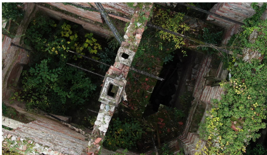
Figura 3.23: Vista sulle scale, foto di IMS Droni: Alessio Villa, novembre 2020
