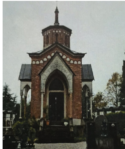
Figura 2.65: S. M. Chiappetta, Cappella Chiappetta. Cimitero di Imberigo. Foto di F. Galli.
