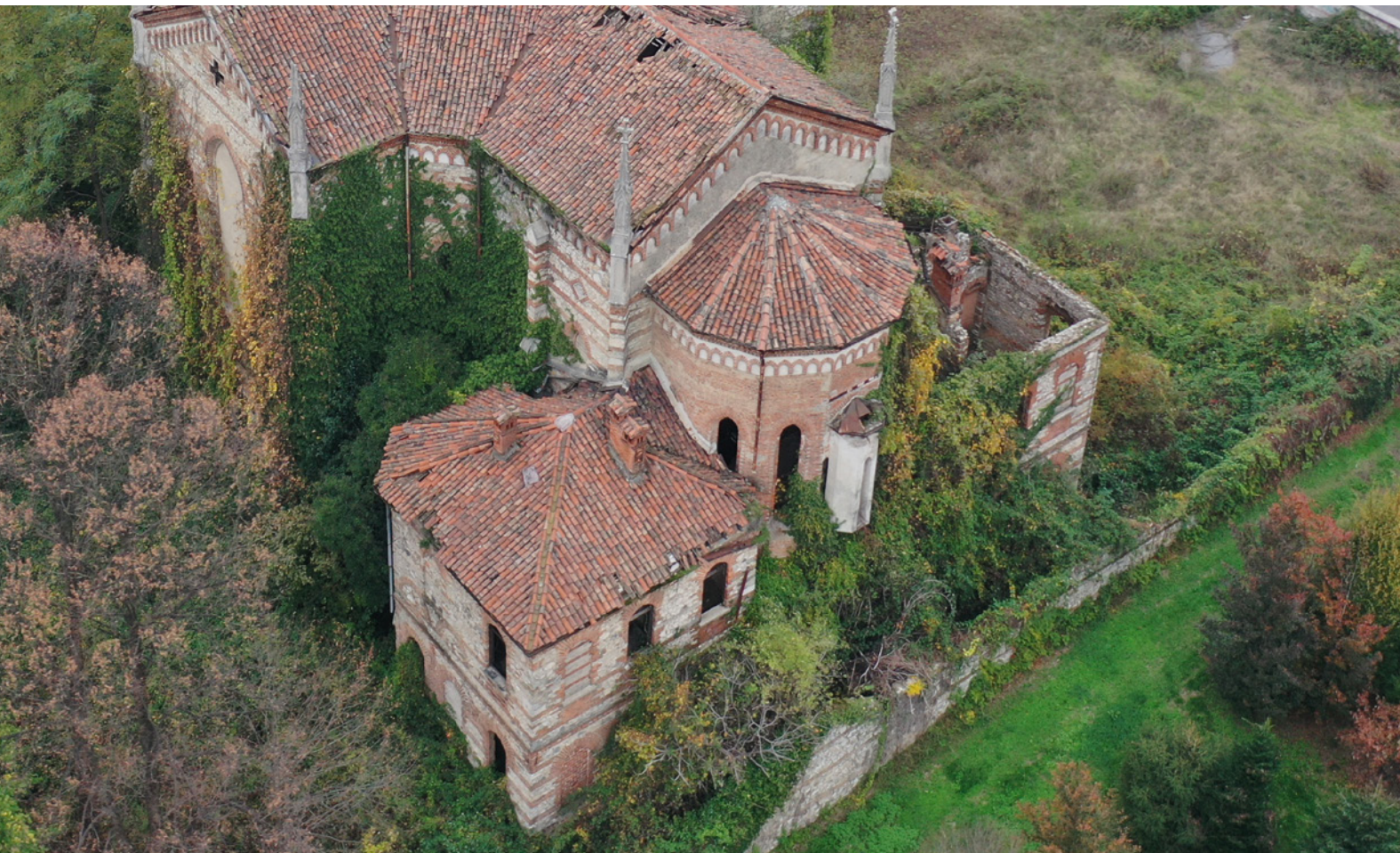
Figura 3.19: Vista sud-est del complesso. In evidenza in corpi accessori retrostanti e l'abside. Foto di IMS Droni: Alessio Villa, novembre 2020
