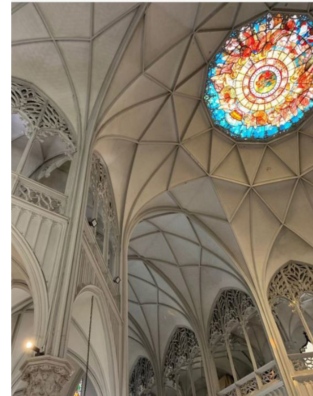
Figura 2.10: Cordonature delle volte nella chiesa di S. Camillo de Lellis, Milano Autore sconosciuto
