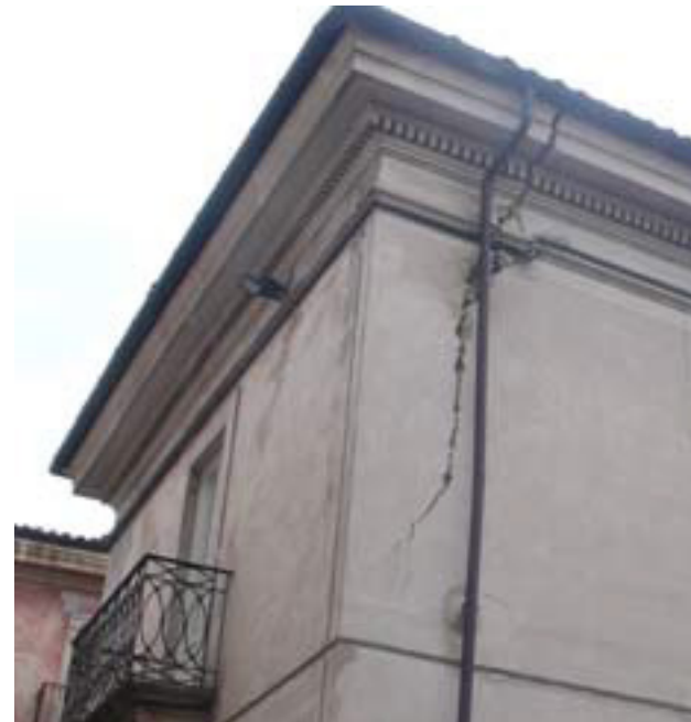
Figura 6.2: caso di un ribaltamento semplice di una parete monolitica. Foto: Arch. Fot. Vice Comm. Del. Beni Culturali - Sisma Abruzzo 2009
