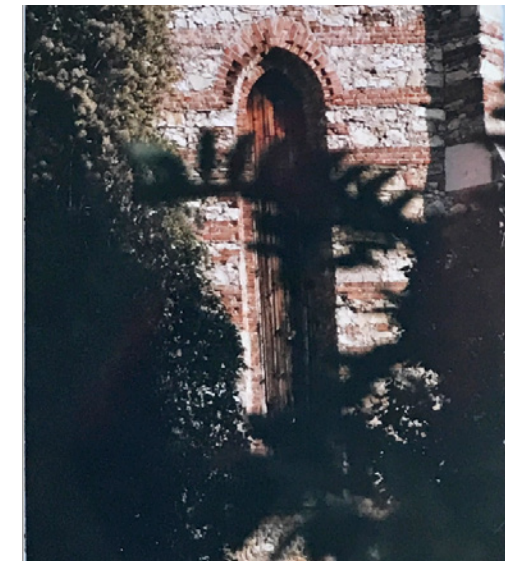
Figura 3.16: Particolare delle finestre del primo piano, foto dell'Arch. Paolo Gatti, 1994
