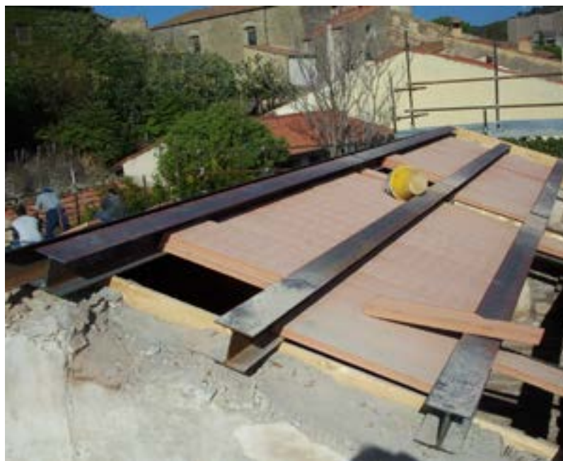
Fig. 24 Posa del nuovo elemento di copertura
