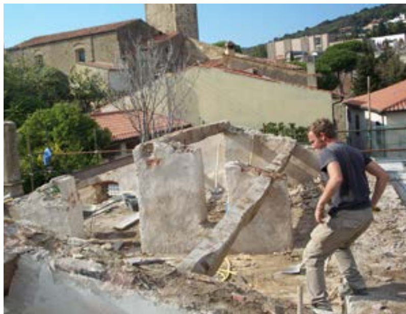
Fig. 21 Smantellamento della copertura originaria (fine 2007)
