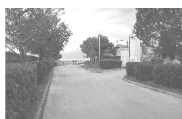
1. Wastewater Treatment: l'impianto per la purificazione delle acque reflue
