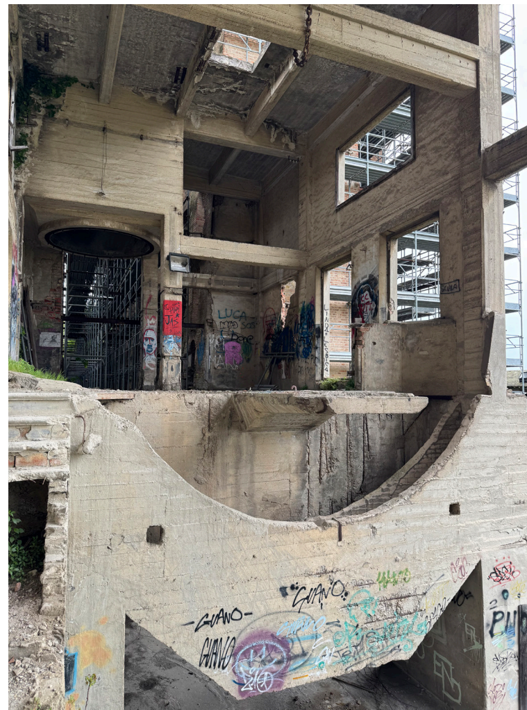
Edificio del forno rotante, vista interna, 2025
