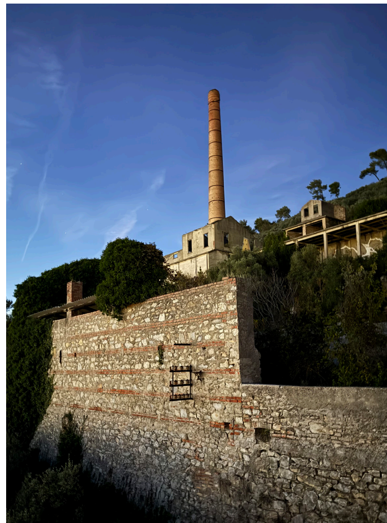
Edificio del forno rotante, vista esterna, 2025
