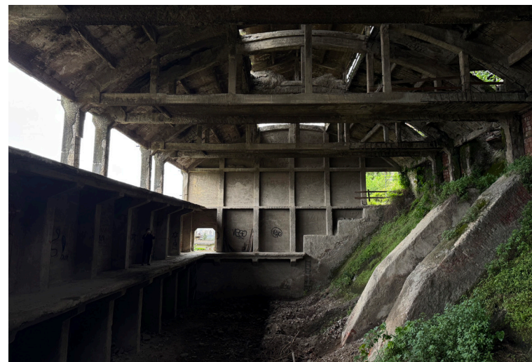
Capannone del Clinker, vista interna, 2025
