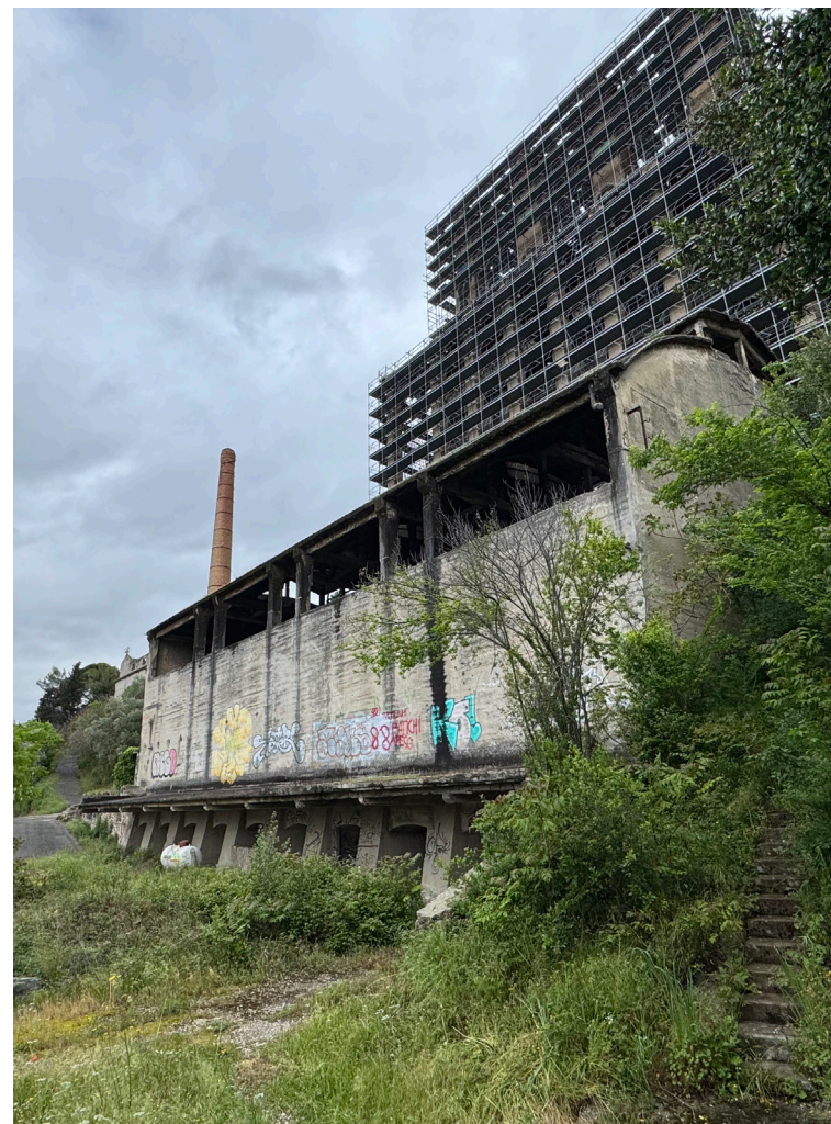
Capannone del Clinker, vista esterna, 2025
