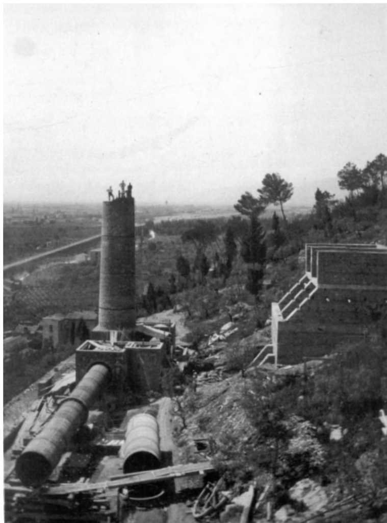
La costruzione della ciminiera del Cementificio, primi decenni del Novecento.
