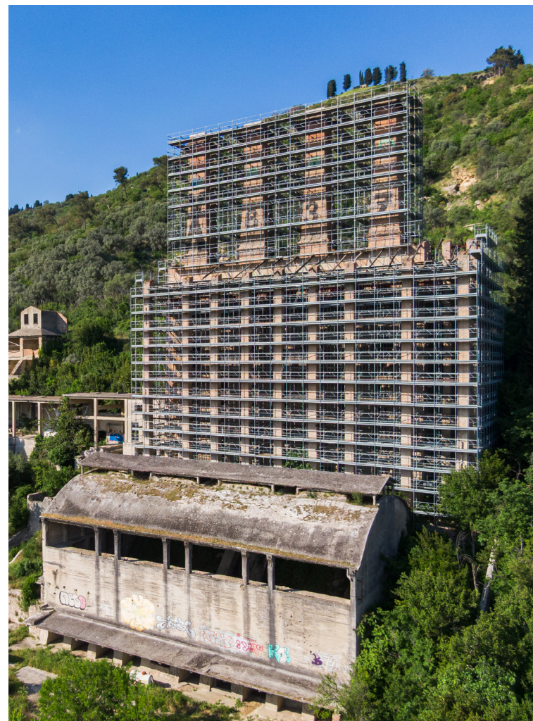
Edificio dei forni verticali, vista aerea, 2025
