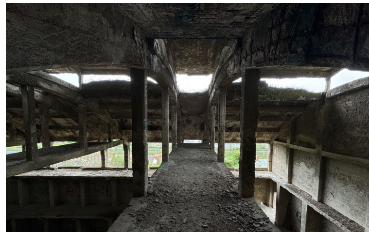
Capannone del Clinker, vista interna, 2025
