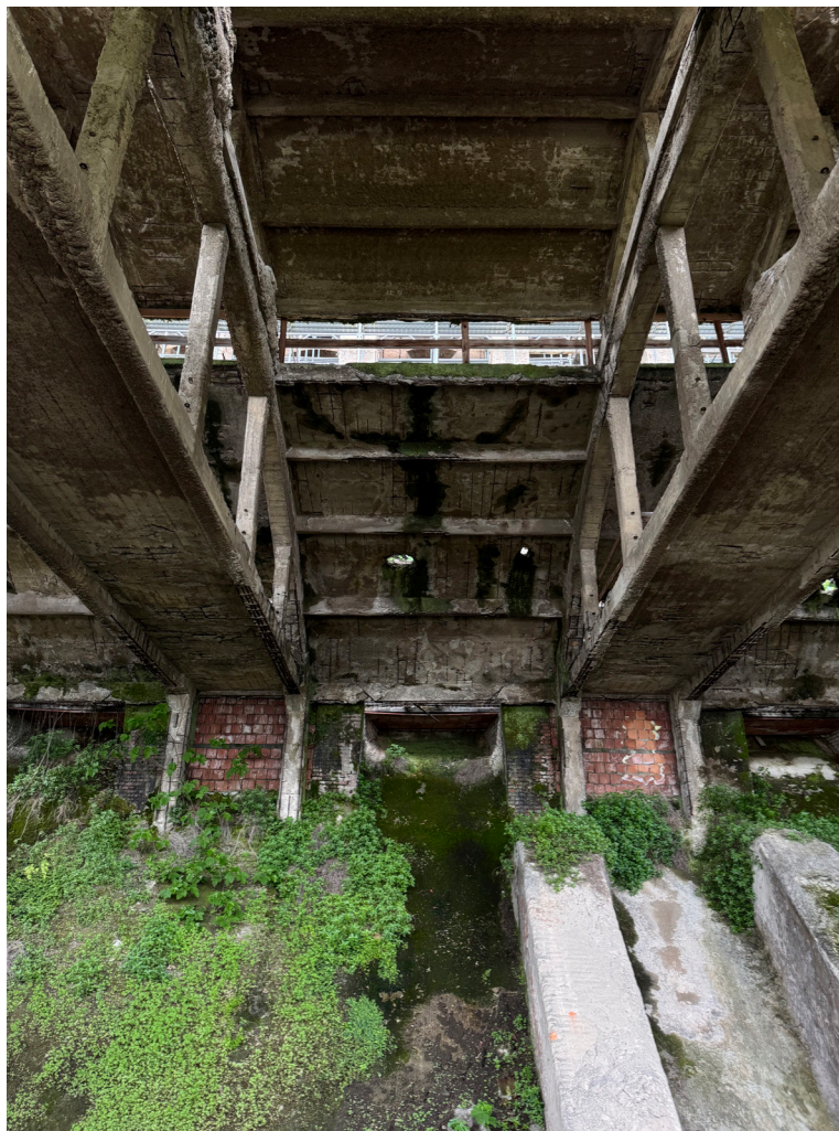
Capannone del Clinker, vista interna, 2025
