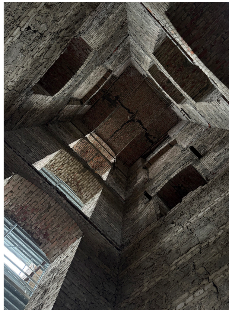
Edificio dei forni verticali, vista interna, 2025
