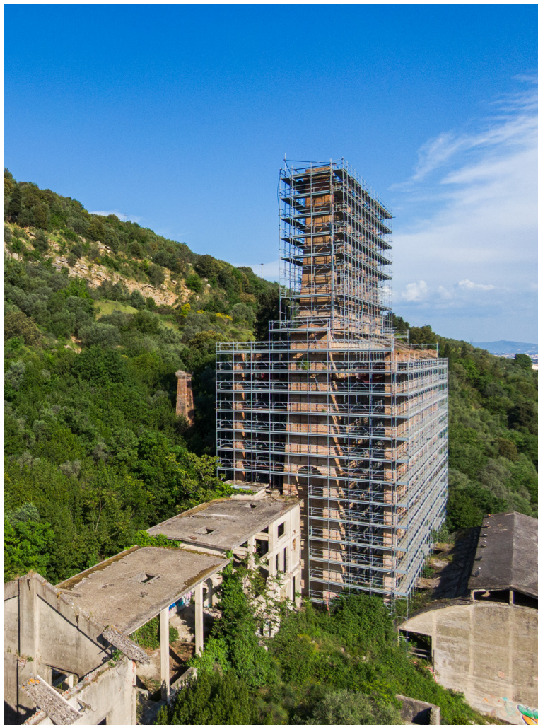
Edificio dei forni verticali, vista aerea, 2025
